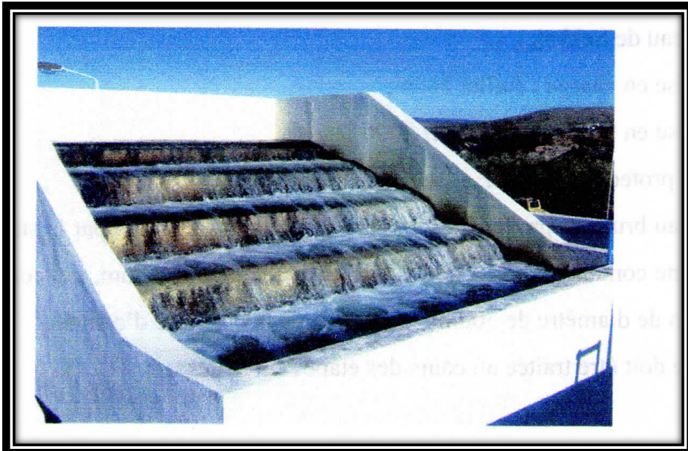
Figure (IV-3) : Cascade d'aération.
