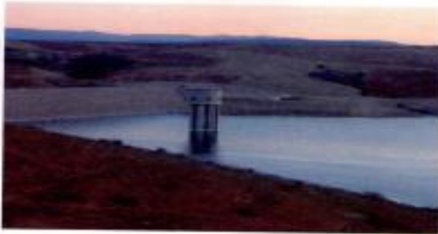
Figure (IV-2) : Barrage SEKKAK.
