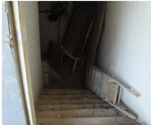
Photo 6 : Accès à un vide sanitaire de la cité des 500 logements. Commune de Mansourah (22 avril 2012)
