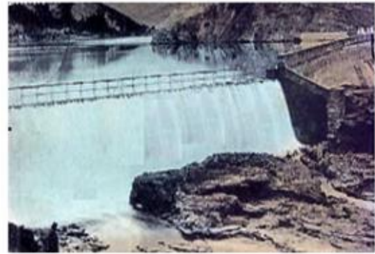
Le barrage de Fergoug en déversement
