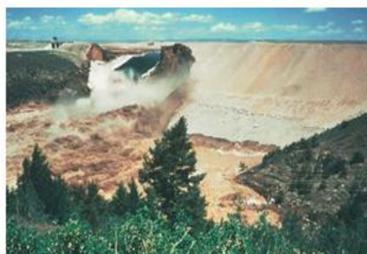
Rupture du barrage de Teton (USA)
