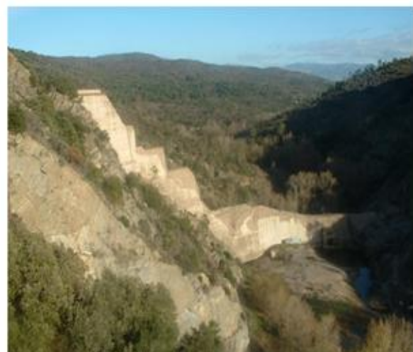
Rupture du barrage de Malpasset (France)
