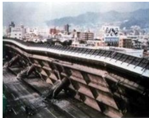
b) Pont détruit par le séisme de Kobe
