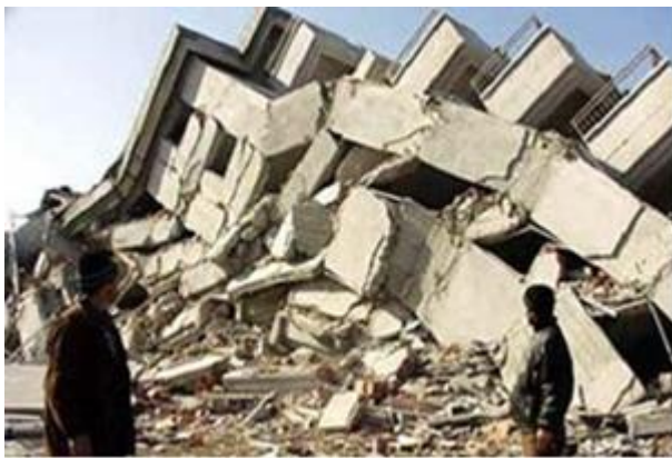
a) Un bâtiment effondré par le séisme de boumerdès
