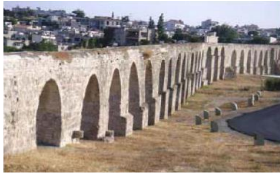
Figure 3.3 : Aqueduc de Larnaka, Chypre.
