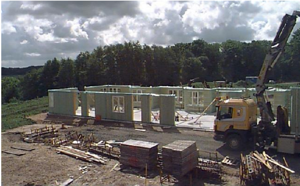
Figure 1.18. Installation des éléments préfabriqués
