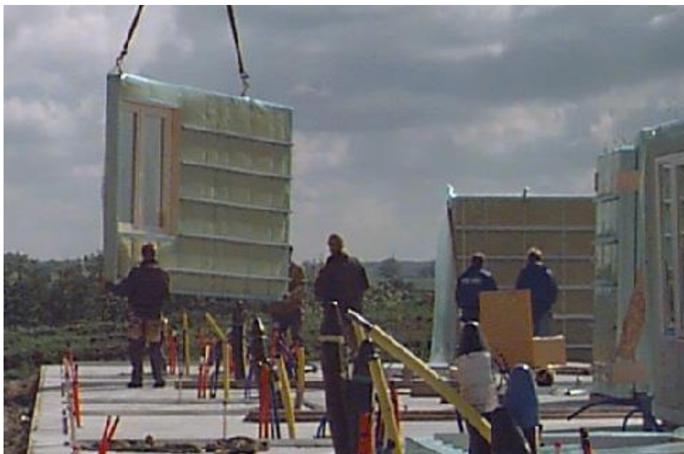
Figure 1.17. panneaux de murs à ossature en profilés d'acier formés à froid
