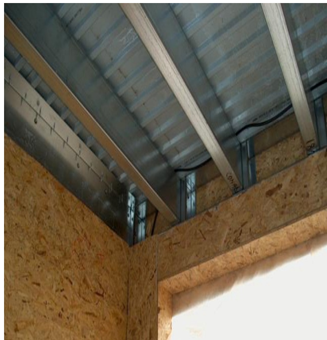
Figures 1.20. poutrelles d'acier formées à froid positionnées sur la structure mur à ossature portante
