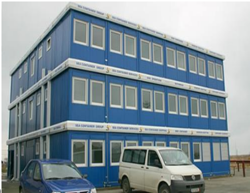
Figure 1.28. Unités modulaires préfabriqués utilisés pour les écoles et les bureaux: a) Ecole Américaine à Bucarest b) Immeuble de bureaux c) des conteneurs groupés
