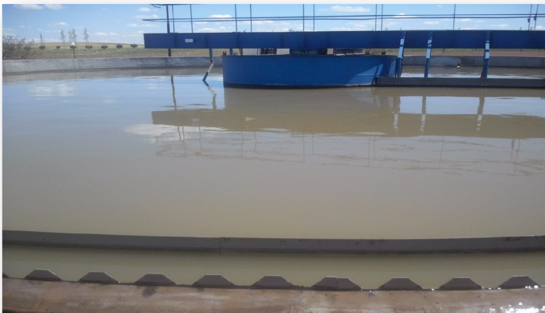
Photo II -9 : Décanteur primaire (TALEB.I, AHMED BRAHIM.D, photos prises au site, STEP de sidi bel abbes, 2014).
