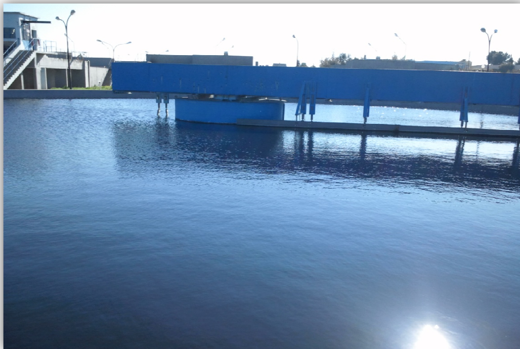
Photo II -15 : Décanteur secondaire (TALEB.I, AHMED BRAHIM.D, photos prises au site, STEP de sidi bel abbes, 2014).
