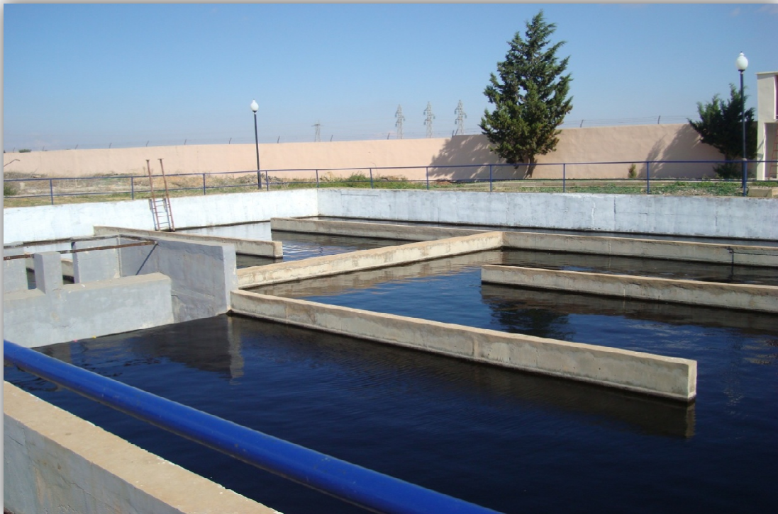
Photo II -17 : Bassin de chloration (TALEB.I, AHMED BRAHIM.D, photos prises au site, STEP de sidi bel abbes, 2014).
