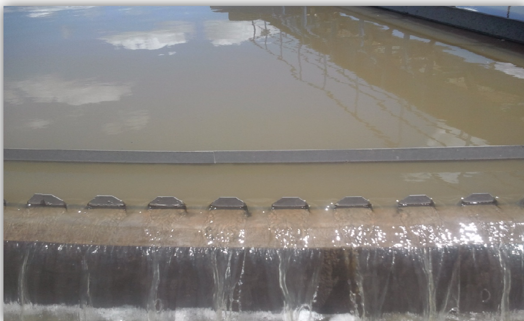
Photo II -10 : Décanteur primaire (TALEB.I, AHMED BRAHIM.D, photos prises au site, STEP de sidi bel abbes, 2014).
