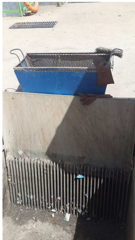
Photo II -5 : Dégrilleur (TALEB.I, AHMED BRAHIM.D, photos prises au site, STEP de sidi bel abbes, 2014).
