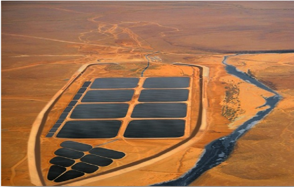
Figure I.5 : Une station d'épuration d'eau par lagunage de Ghardaïa [29].
