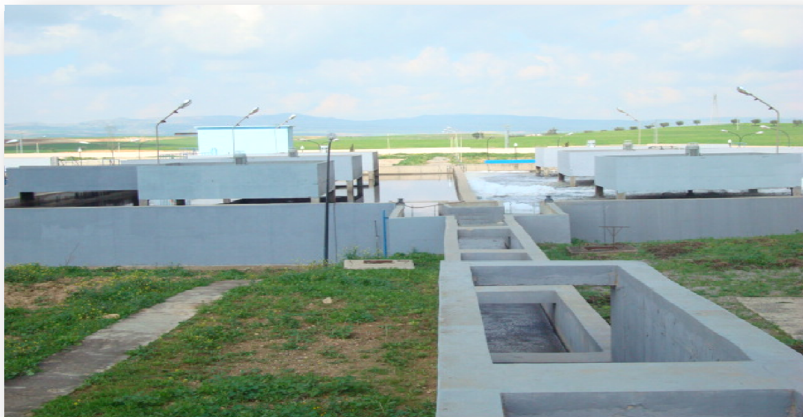
Photo II -11 : Canal vers bassin d'aération (TALEB.I, AHMED BRAHIM.D, photos prises au site, STEP de sidi bel abbes, 2014).
