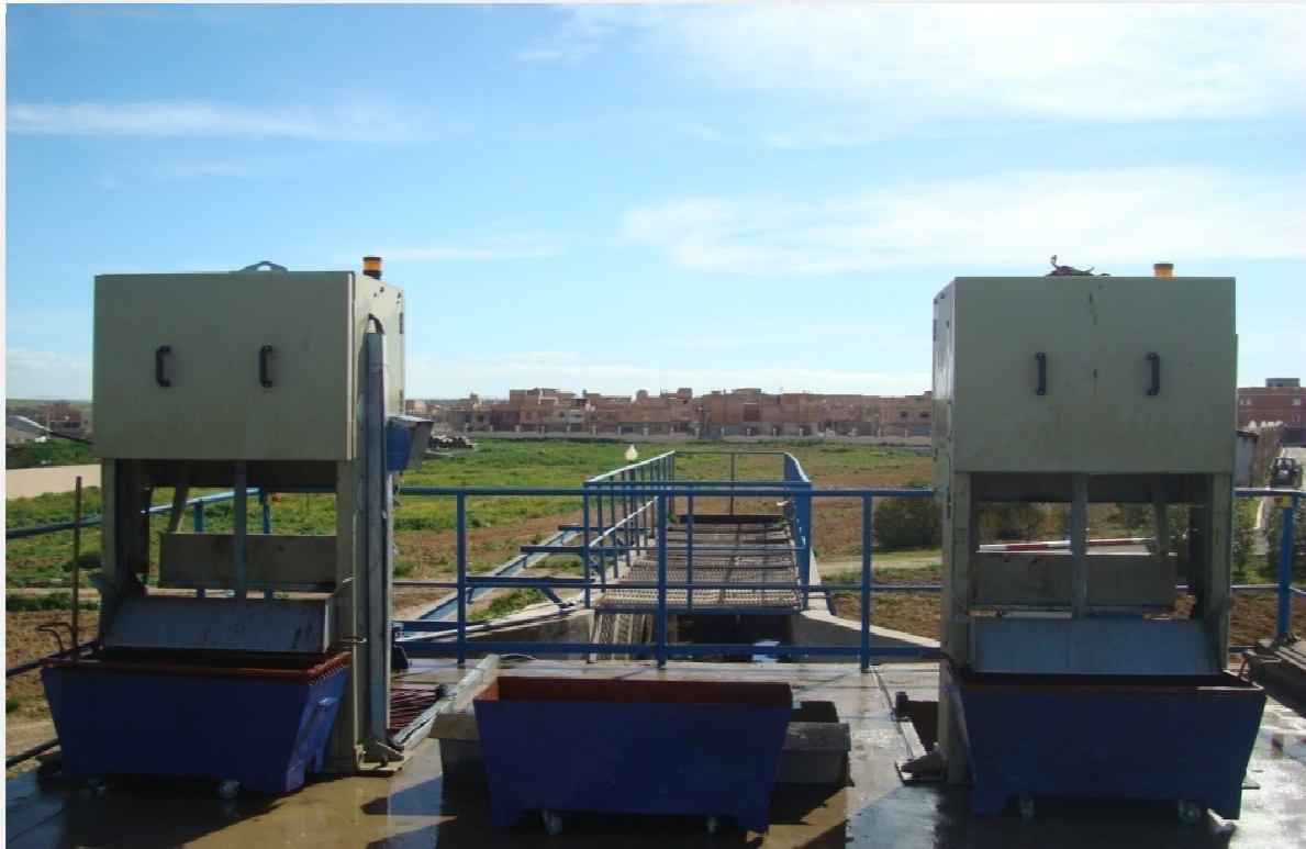
Photo II -5 : Dégrilleur (TALEB.I, AHMED BRAHIM.D, photos prises au site, STEP de sidi bel abbes, 2014).
