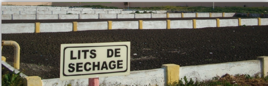
Photo II -20 : Lits de séchage (TALEB.I, AHMED BRAHIM.D, photos prises au site, STEP de sidi bel abbes, 2014).
