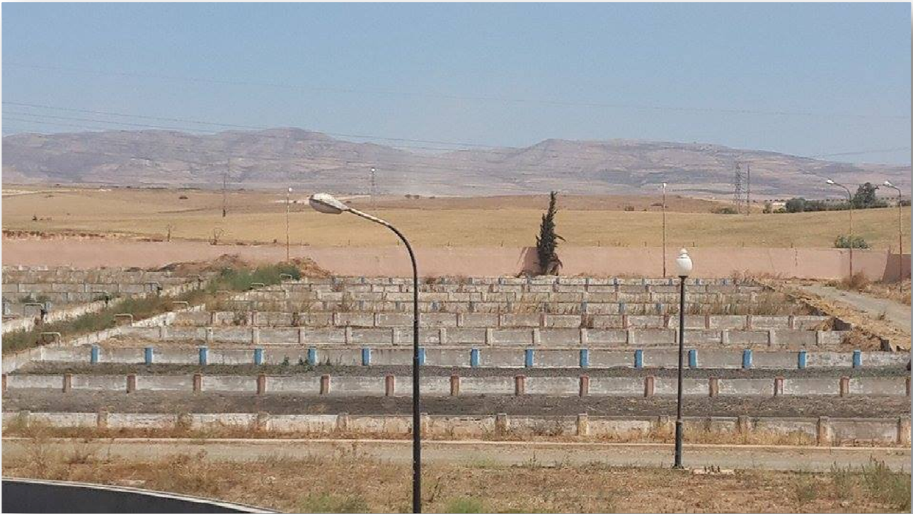
Photo II -21 : Lits de séchage (TALEB.I, AHMED BRAHIM.D, photos prises au site, STEP de sidi bel abbes, 2014).
