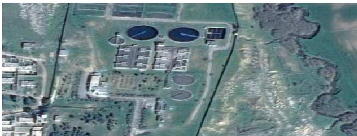
Photo II -2: Vue de la Station d'épuration de Rochet (Sidi Bel Abbès). (Google earth)[37]
