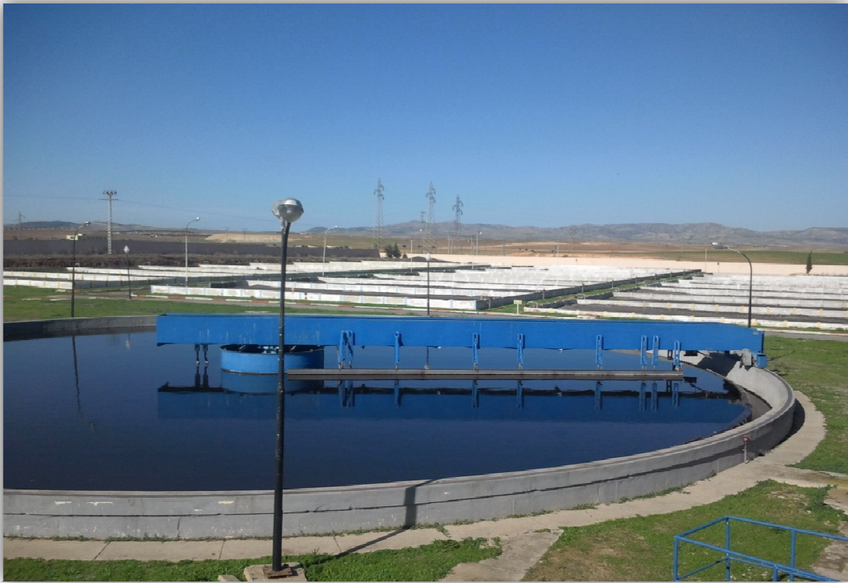
Photo II -14 : Décanteur secondaire (TALEB.I, AHMED BRAHIM.D, photos prises au site, STEP de sidi bel abbes, 2014).
