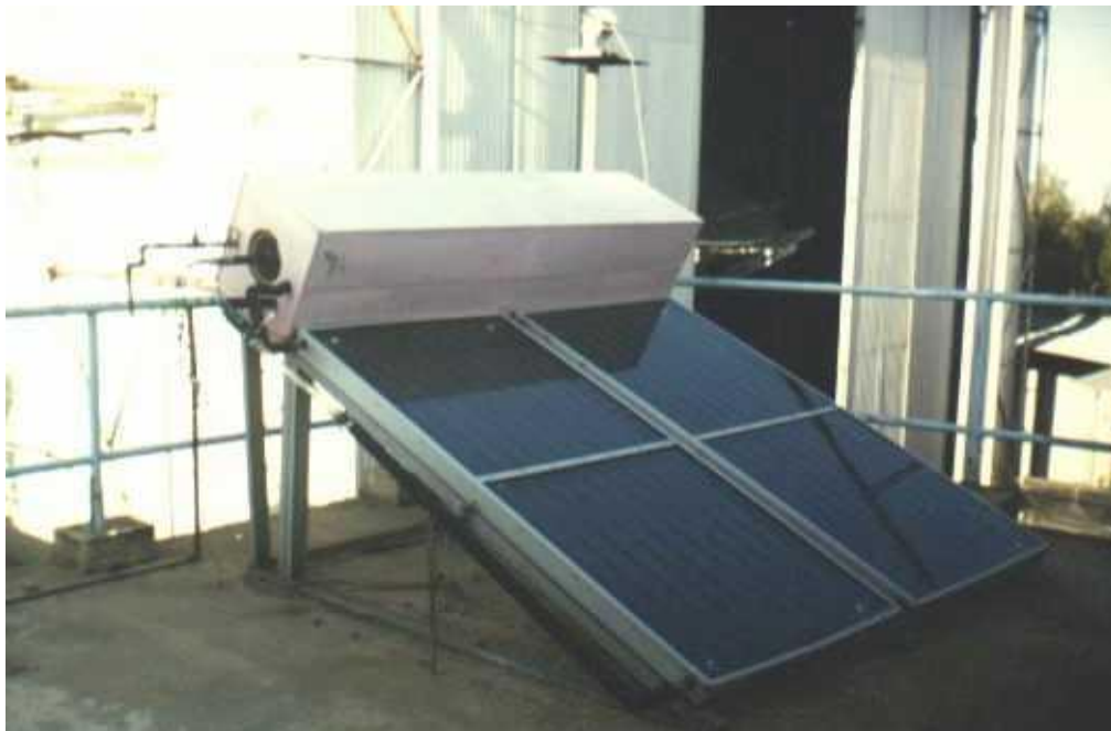
Figure III-4 : Photo montrant le chauffe-eau solaire développé par le CDER et fabriqué par l'UDES, [18]
