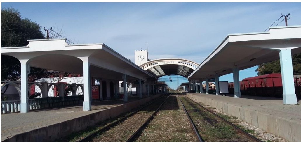
Figure 2.3: Vue en profil de la toiture existante
