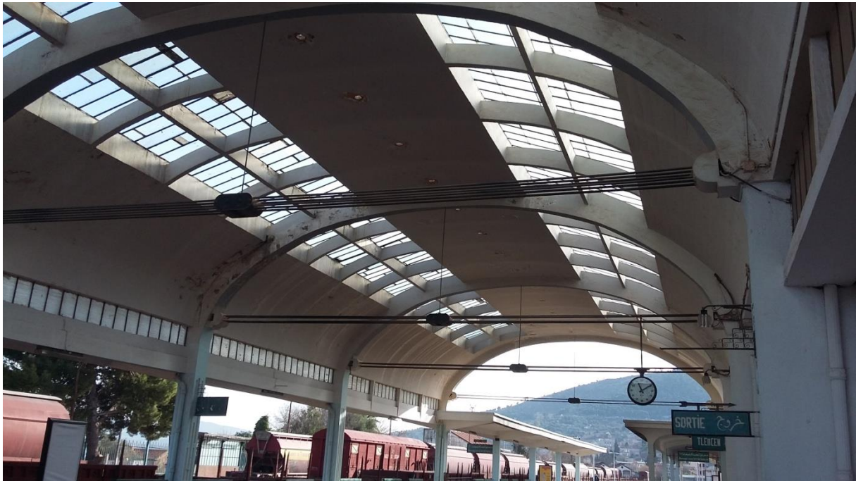
Figure 2.4: Vue intérieure de la toiture existante
