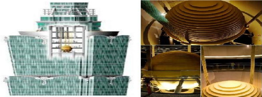
Figure I. 26 : Un TMD pendulaire de 800 tonnes dans un bâtiment de 508m de hauteur (tour de Taipei 101) Taiwan.
