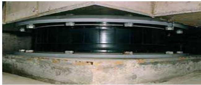
Figure I. 13 : Appuis en élastomère à fort taux d'amortissement
