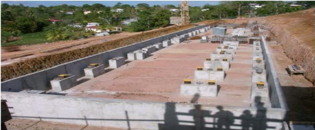
Figure I. 1 : Mise en place des isolateurs sur les massifs d'une structure.
