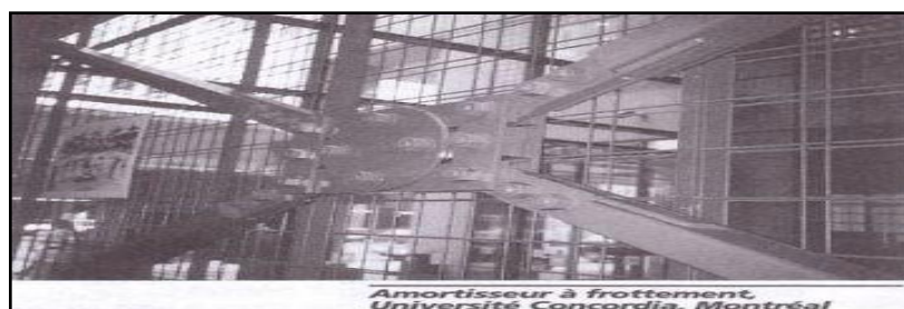
Figure I. 25 : Amortisseur à friction.
