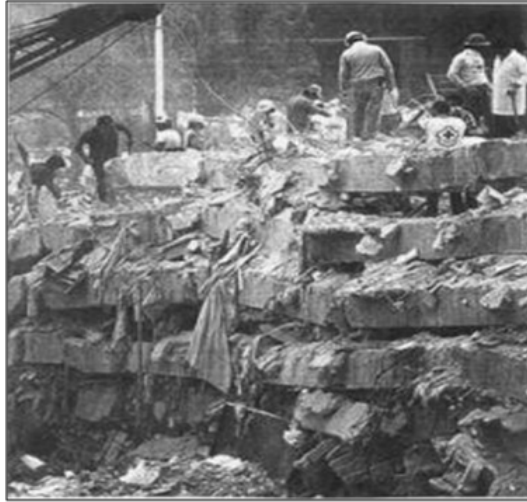
FIGURE 1.8 – Empilement des planchers après séismes
