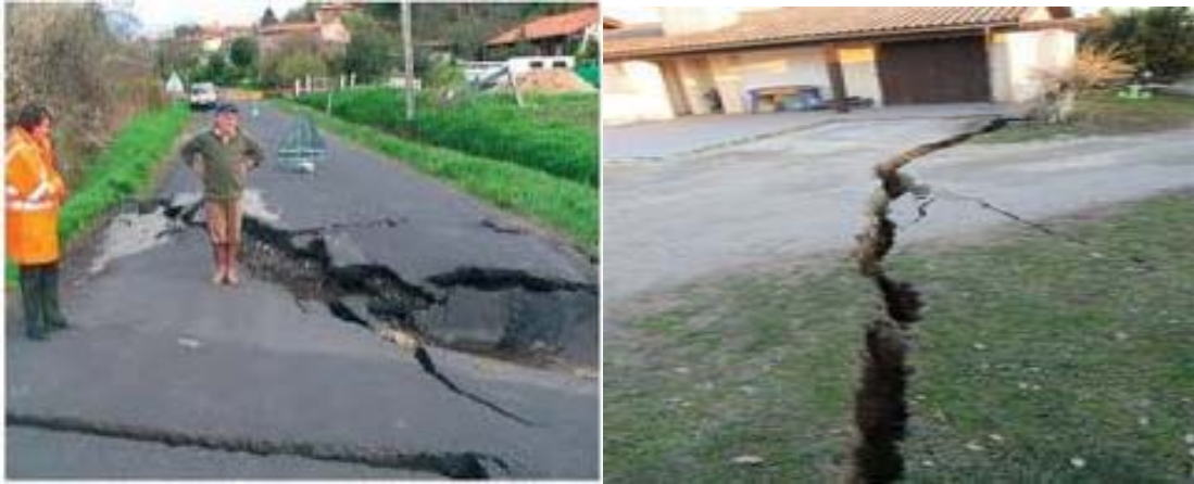
Figure 1.11 : Des exemples de désordres dans le monde à partir de Google.
