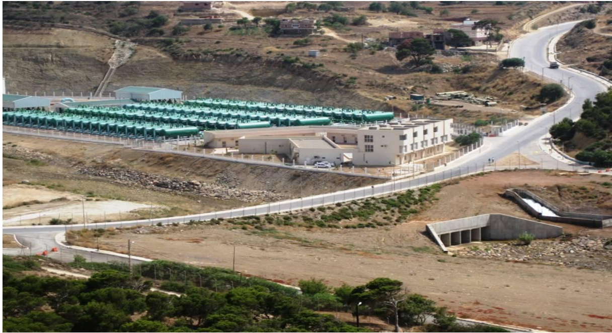
Photo IV.1 : Photo de la station de dessalement de Honaine
