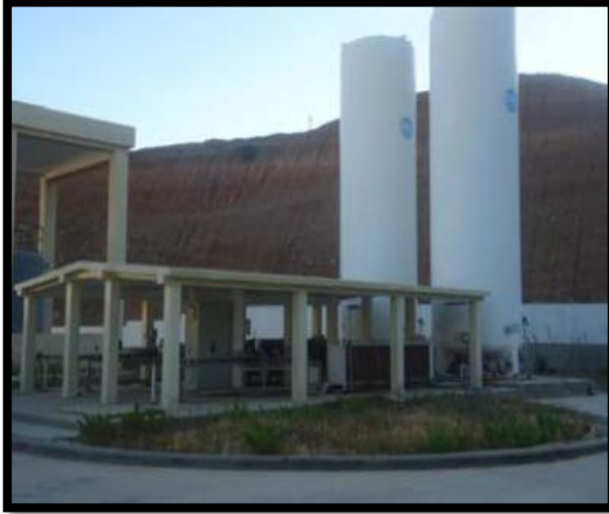
Figure IV.9: Système de dosage du CO 2 . Figure IV.10: Système de dosage de la chaux.
