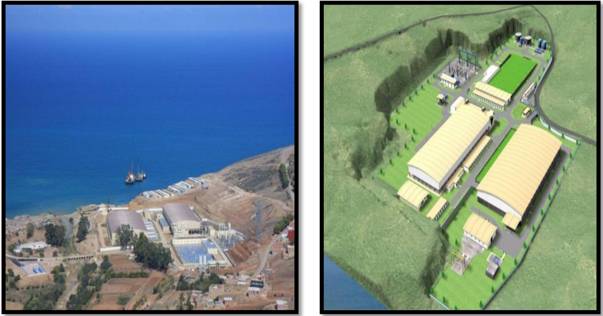
Figure IV.1 : Station de dessalement de Souk Tleta .
