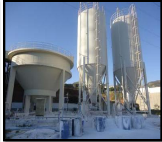
Figure IV.9: Système de dosage du CO 2 . Figure IV.10: Système de dosage de la chaux.
