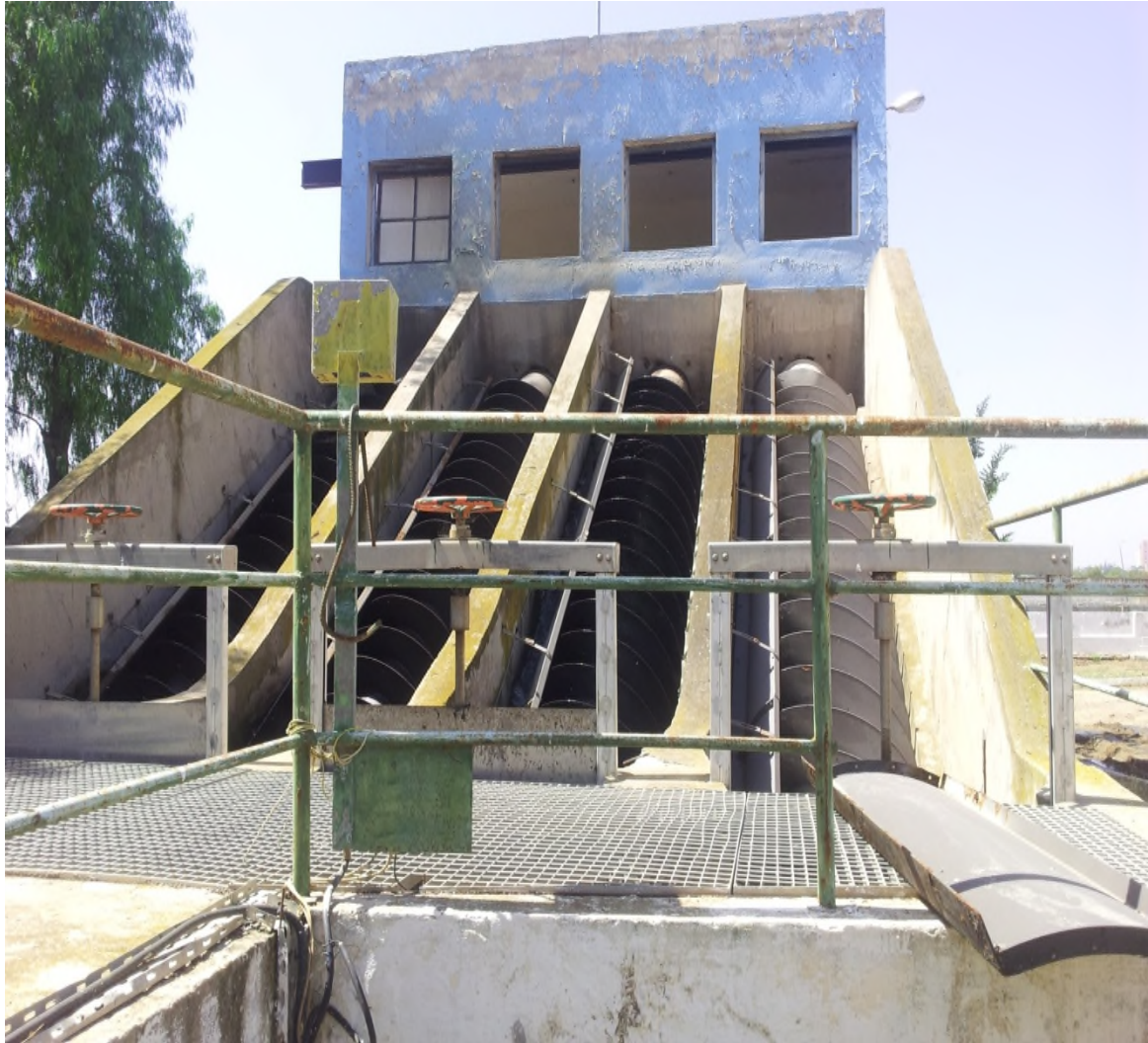
Figure II.4 : bâtiment de relevage.
