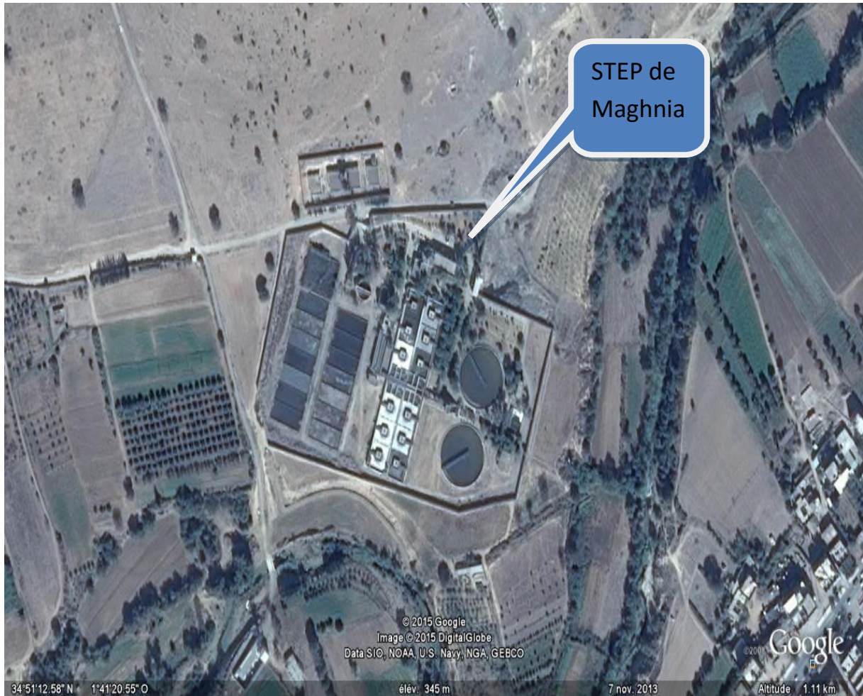
Figure II.1: Vue de la station d'épuration de Maghnia.
