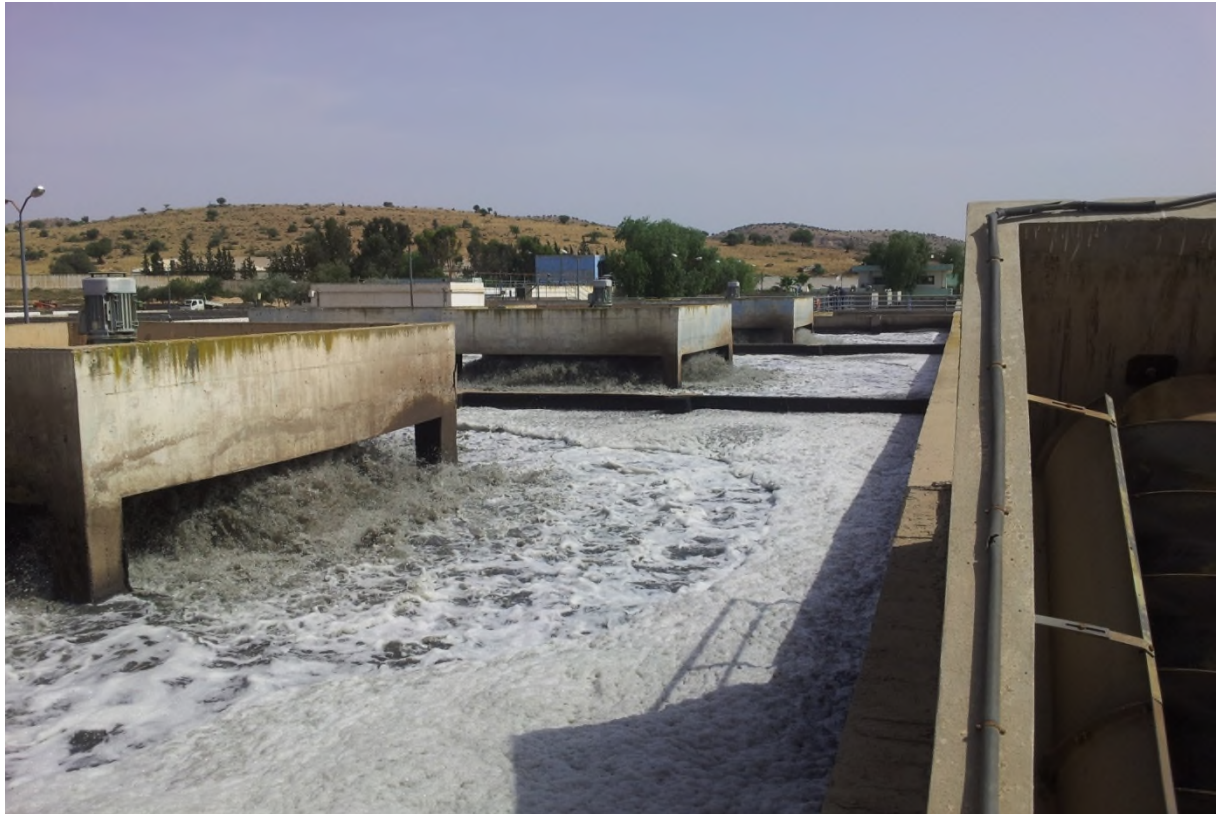
Figure II.10: Bassins d'aérations
