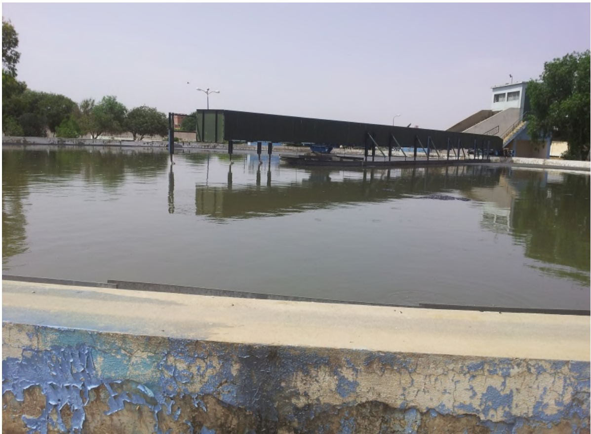
Figure II.11: Décanteurs secondaires.
