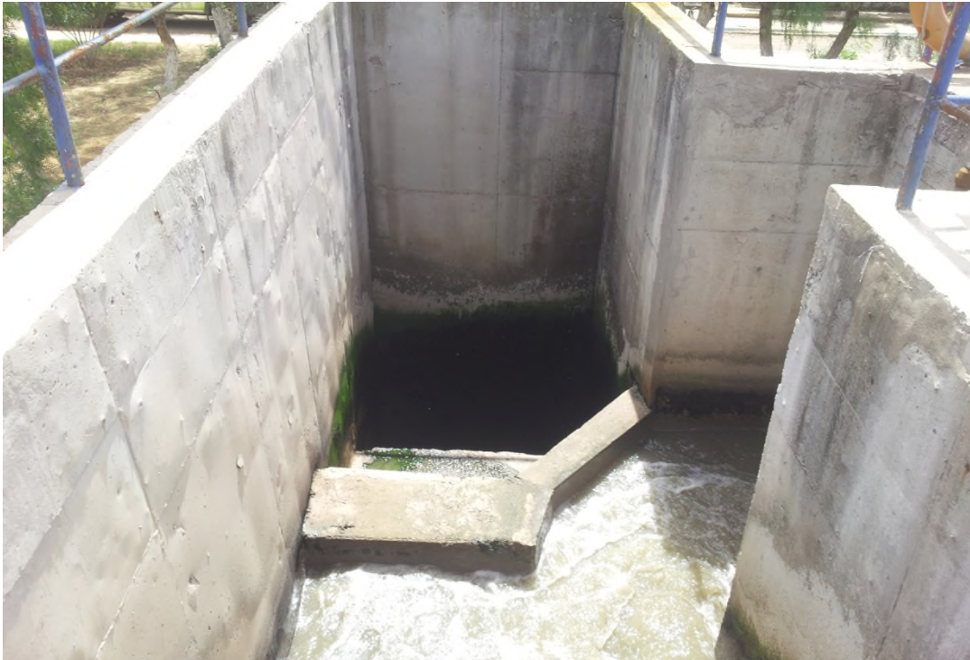
Figure II.2: Déversoir d'orage.
