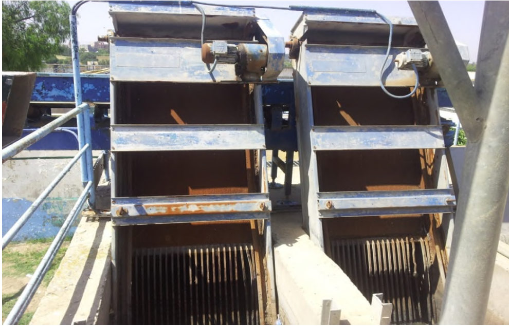
Figure II.5. Grilles mécaniques.
