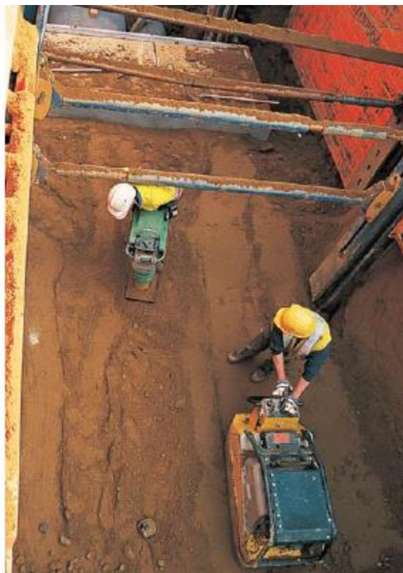
Figure IV.1 : compactage du lit [24]
