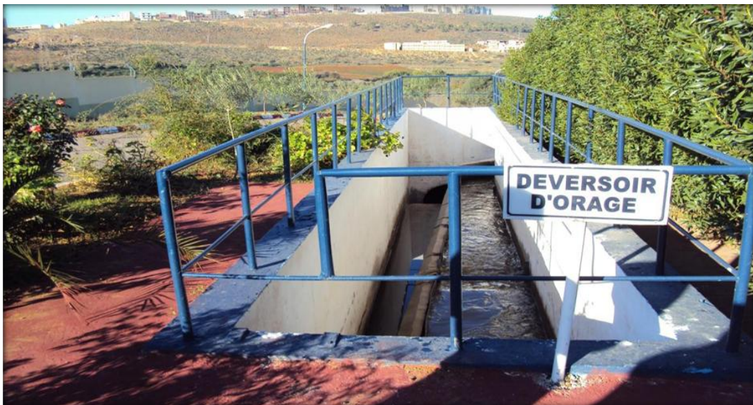
Figure III.3: Photo du déversoir d'orage
