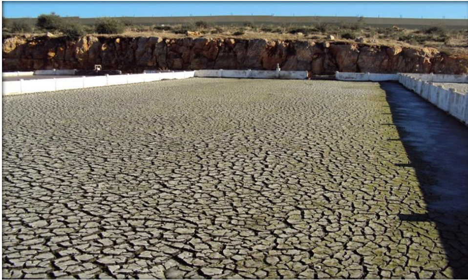
Figure III.13 : Photo d'un lit de séchage
