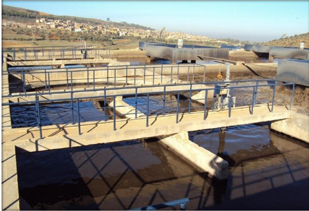
Figure III.8 : Photo du Bassin de nitrification dénitrification
