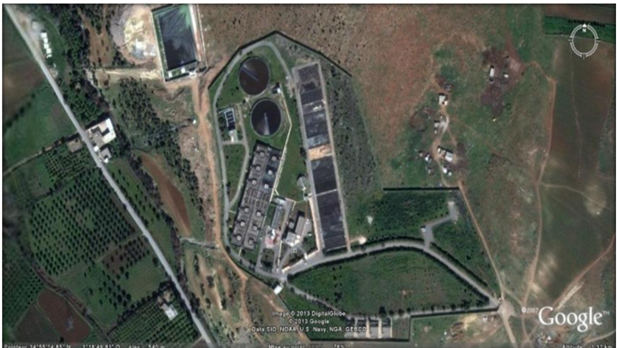
Figure III.1: Vue de la station d'épuration d'Ain El Houtz (Tlemcen) [31].
