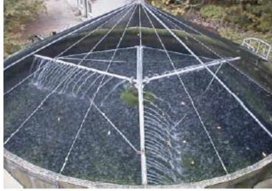
Figure II.2. Lit bactérien avec garnissage traditionnel [42].
