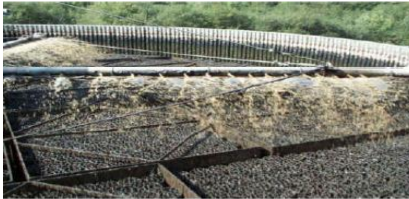
Figure II.3. Alimentation du lit bactérien (garnissage plastique)[43]
