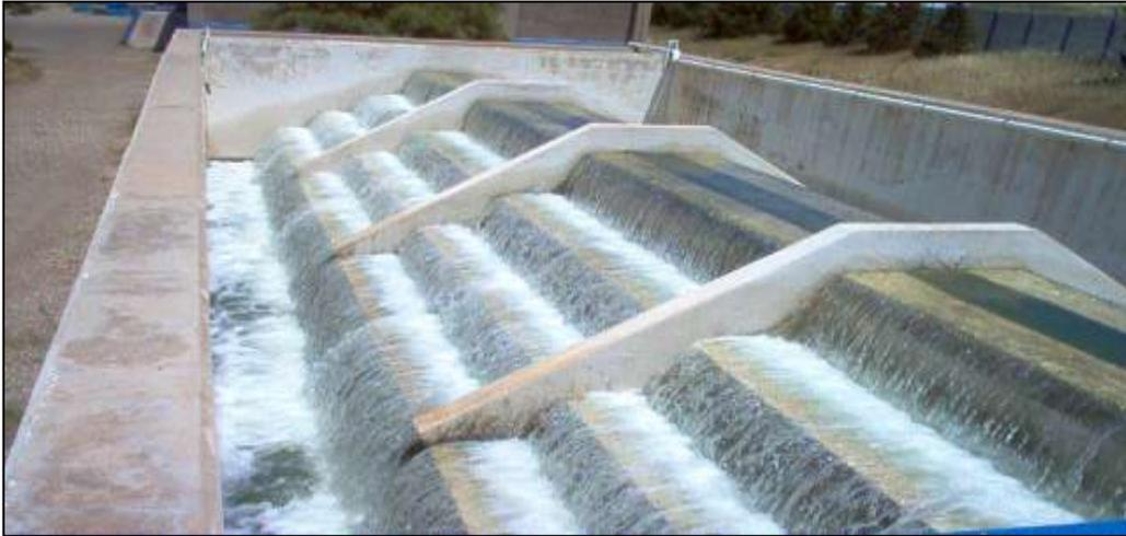
*Figure II.29 : Cascade d'aération*
