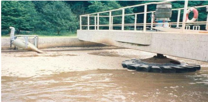
Figure II.5 : Turbine d'aérateurs de surface[25]
