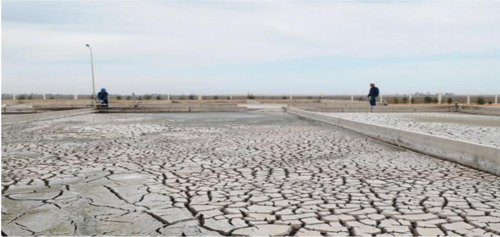
Figure II.9 : Un lit de séchage[29].
