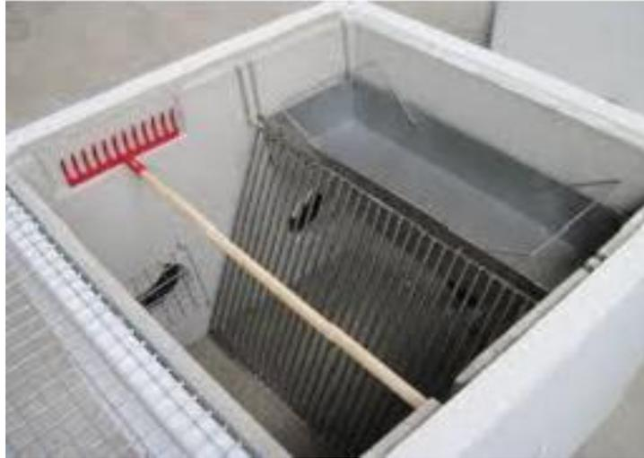
**Figure II.1:** Un dégrilleur manuel avec un râteau [14].
