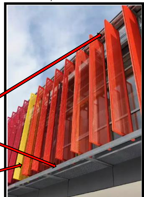
Figure 135 : façade d'une école élémentaire
