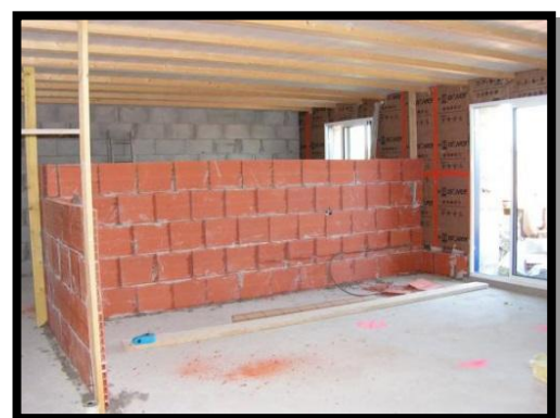
Figure 143 : mur de séparation
