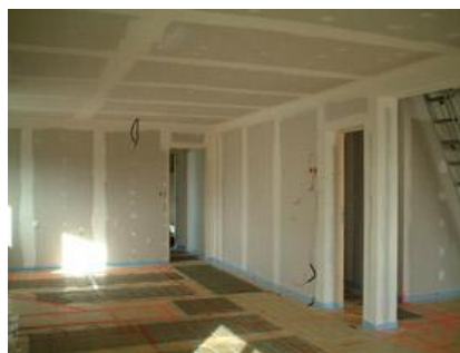
Photo 83 : Cloisons en Placoplatre 12
