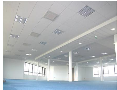
Photo 89 : Faux plafond suspendu
