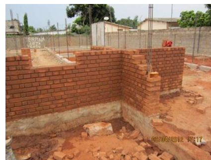
Photo 87 : Mur en BTC 17
