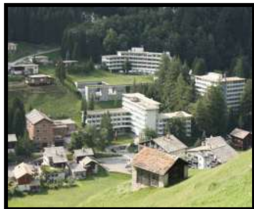
Figure 55 : vue sur le projet
