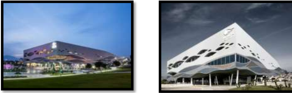
Figure 46 : vues par l'extérieur
