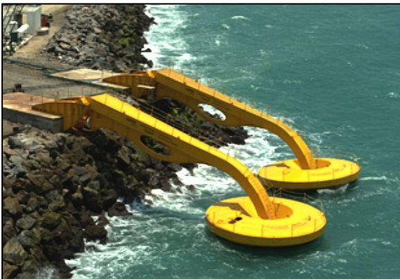
Figure 156 structure du capteur fixé dans la digue
