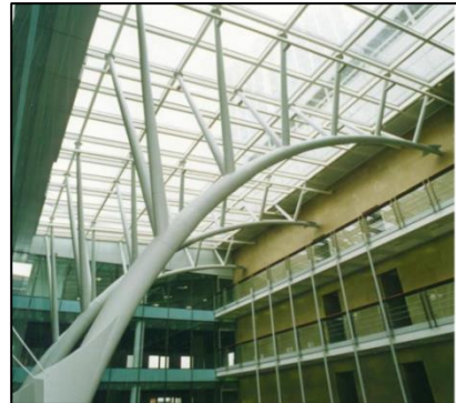
Figure 140 structure en arc tubulaire.
