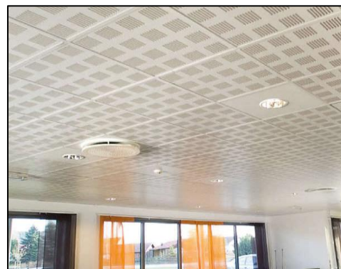
Figure 149 faux plafond s'un immeuble à bureaux
