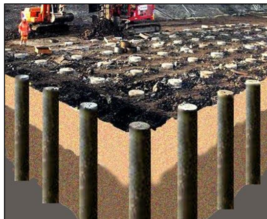
Figure 129 Regroupement de pieux dans un chantier
