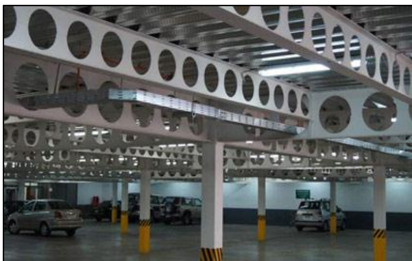
Figure 136 poutres alvéolaires dans un parking
