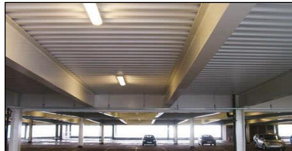
Figure 138 Plancher collaborant réalisé dans un parking
