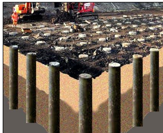
Figure 131 Regroupement de pieux dans un chantier
