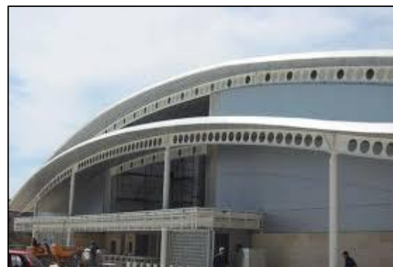
Figure 137 poutres alvéolaires courbées
