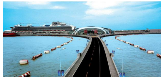
Figure 92 Route d'accès du terminal
