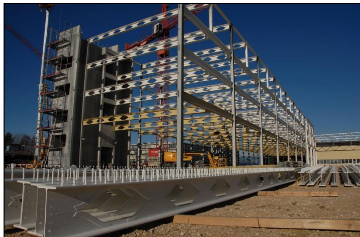
Figure 134 Structure mixte en chantier
