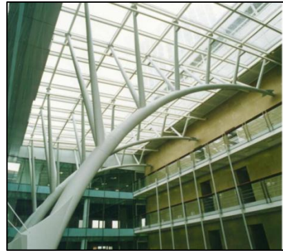
Figure 142 structure en arc tubulaire.
