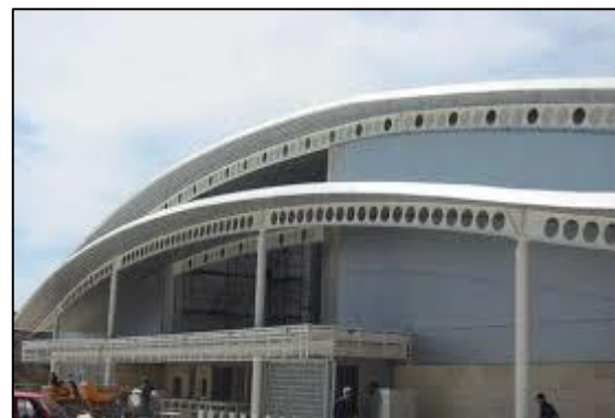
Figure 135 poutres alvéolaires courbées
