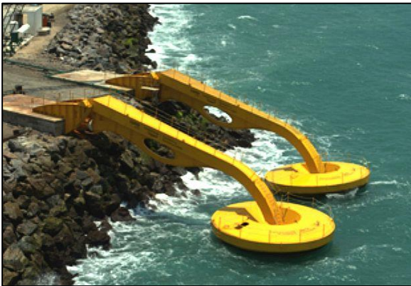
Figure 154 structure du capteur fixé dans la digue
