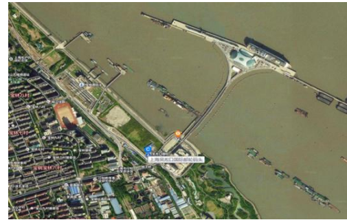
Figure 91 vue aérienne du terminal
