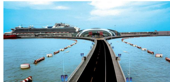
Figure 92 Route d'accès du terminal
