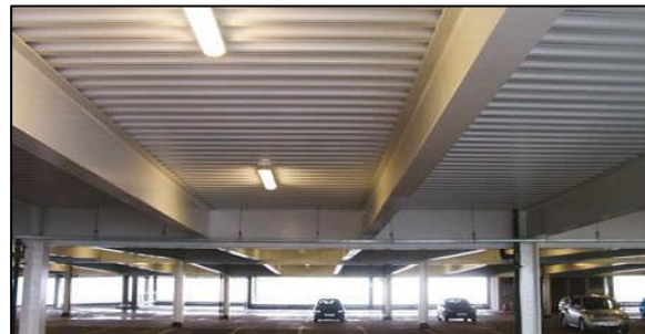
Figure 140 Plancher collaborant réalisé dans un parking
