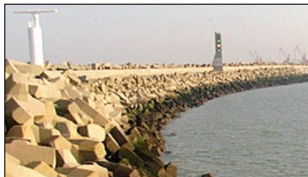
Figure 122 une digue sur le large
