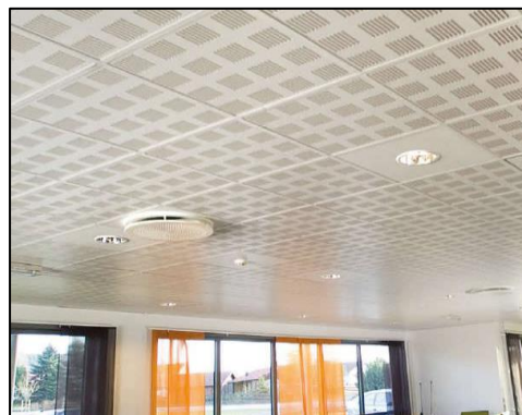
Figure 147 faux plafond s'un immeuble à bureaux
