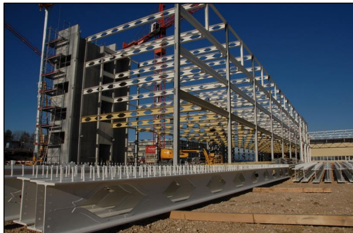
Figure 132 Structure mixte en chantier
