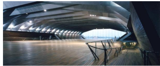
Figure 53 Intérieur du terminal
