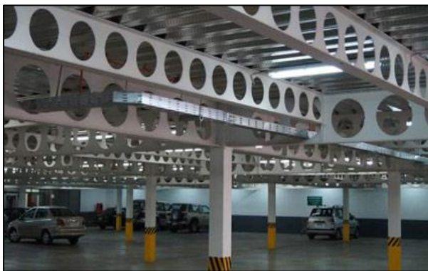
Figure 134 poutres alvéolaires dans un parking
