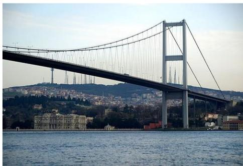
Figure 8: Pont suspendu sur le Bosphore, Istanbul , Turquie ,(Portée principale : 1074 m ) . Source : <http://images-mds.staticskynet.be/NewsFolder/original/SKY20100311025155AL.jpg> .(dernier accès le 21/11/2015)
