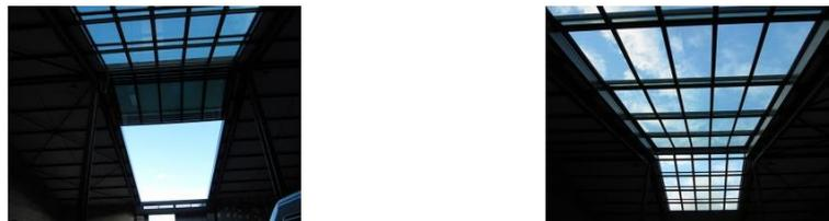
Figure 85 :exemple de verrière coulissante .Source : <http://www.toitel.com/toiture-coulissante/> (dernier accès le 27/03/2016)
