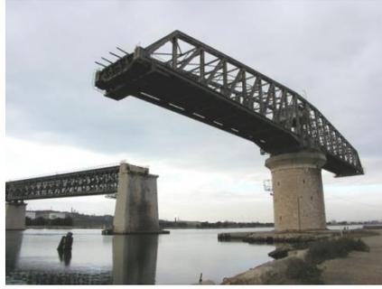
Figure 14: Pont tournant du viaduc de Caronte , Bouches-du-Rhône, Provence-Alpes-Côte d'Azur, France (longueur totale : 943 m , longueur travées mouvantes : 57m ) . Source : <http://files1.structurae.de/files/photos/618/caronte1.jpg> . (dernier accès le 21/11/2015) .
