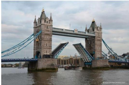
Figure 12: pont basculant le Tower bridge ,Londres ,Angleterre ,Royaume-Uni,(Portée principale : 79 m , longueur totale des travées adjacentes: 82.3m , longueur totale :286.50m ) .
