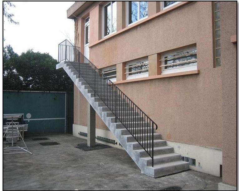
photo 56:escalier de secours en béton armé<sup>147</sup>
