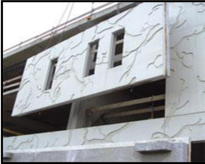
Photo 40: les panneaux préfabriqués<sup>128</sup>
