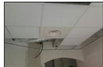
Figure 174 : faux plafond en plaque hydrofuge
