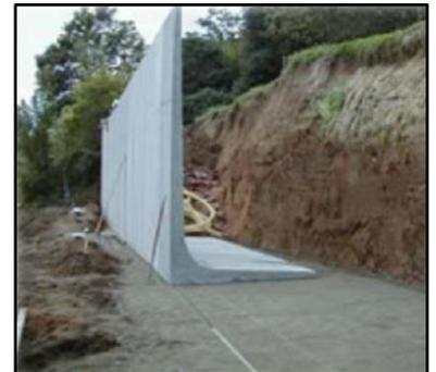
Figure 160: mur de soutènement
