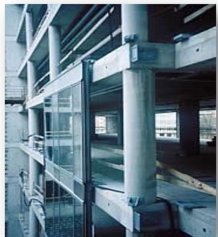
Figure 166 : installation des panneaux
