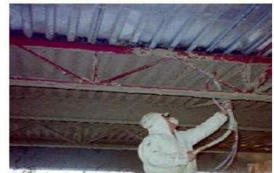
Figure 144:flockage avec plâtre
