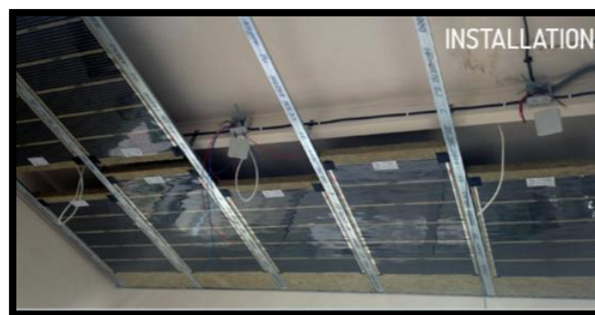
Figure 89 : faux plafonds en pvc
