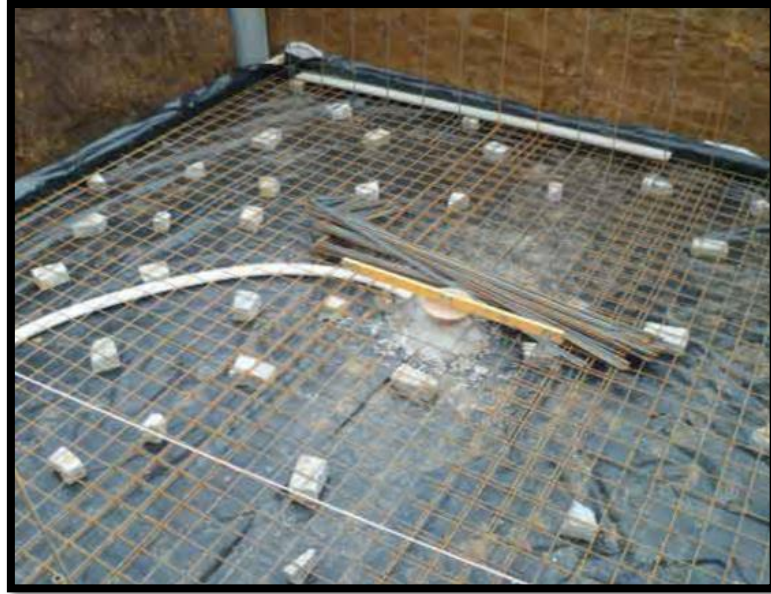
Figure 49: coffrage du radier générale
