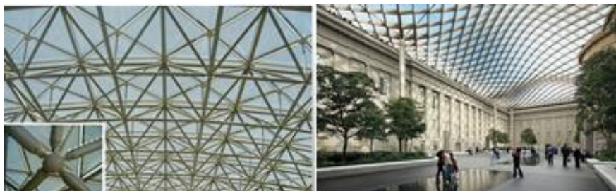
Figure 58 : toiture en coque tridimensionnelle
