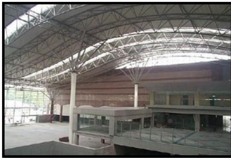
Figure 65 : poutre a treillis tridimensionnel
