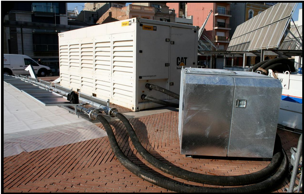
Figure 82 : le groupe de froid accordé a la piste de glace
