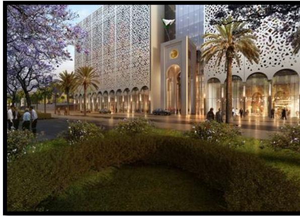
Figure 75 : façade BFUP du nouveau siège du parlement , ALGER
