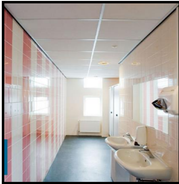
Figure 90: faux plafonds en pvc
