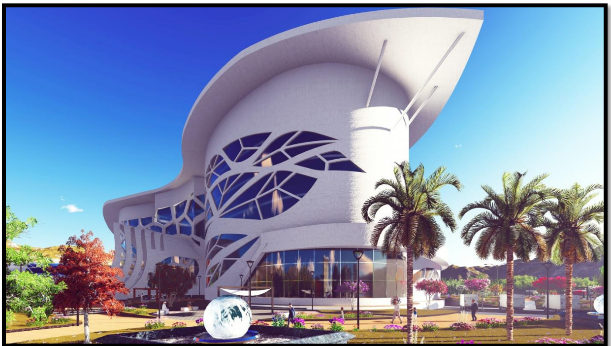
Figure 38 : vue latérale nord
