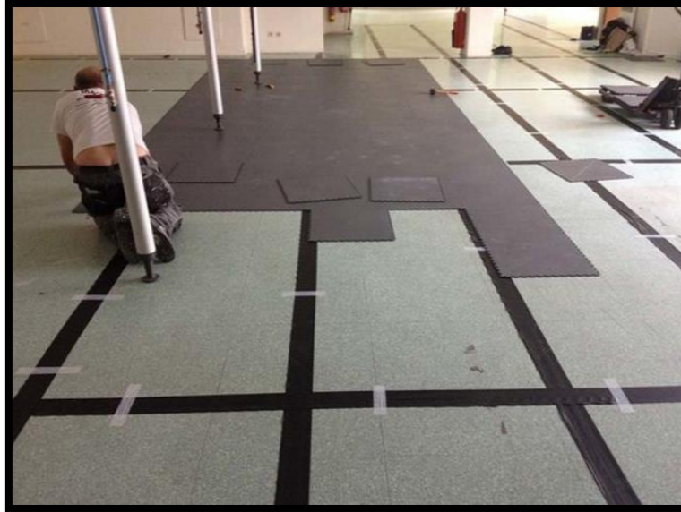
Figure 92 : mise en place du linoléum
