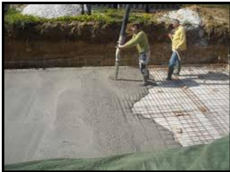
Figure 50: réalisation du radier (coulage du béton )
