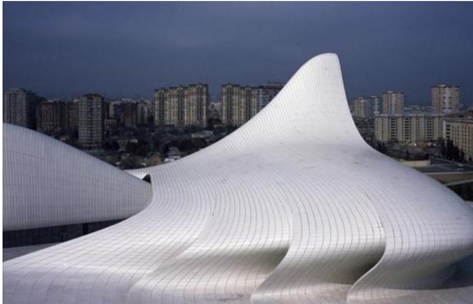
Figure 59 : toiture en polyoléfine thermoplastique ( centre culturelle Azerbaïdjan )
