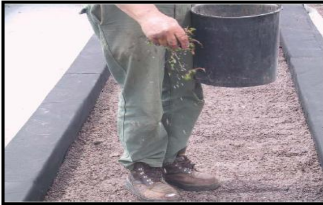
Mise en place de la végétation
