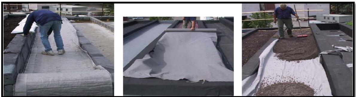
Drainage sous forme de treillis en PE avec voile filtrant
