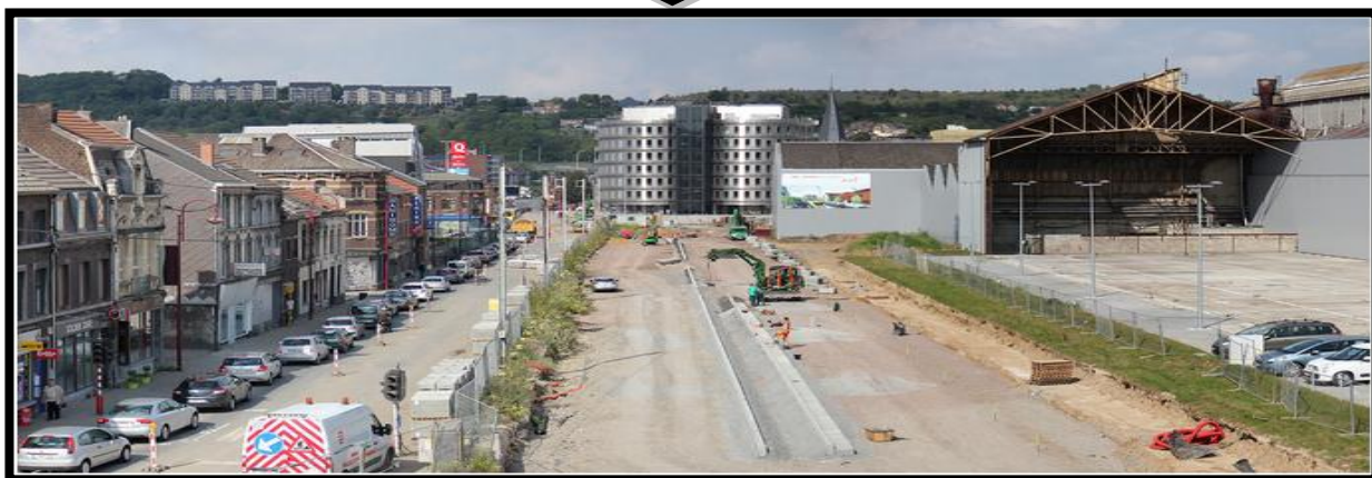
Élargissement de la Rue Cockerill: état d'avancement des travaux, septembre 2014
