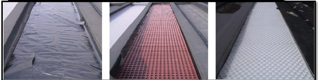
Pose d'un film polyéthylène
