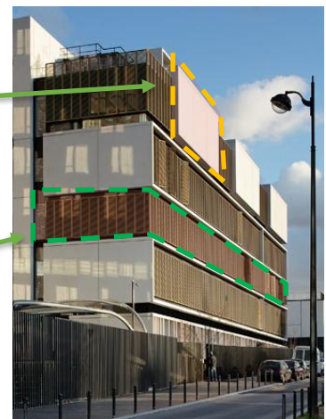
Figure 61: vue de façade principale
