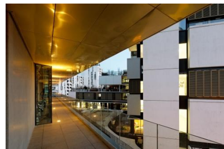
Figure 64:vue sur la coursive extérieure
