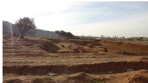
Figure 2.13 : Existant sur site
