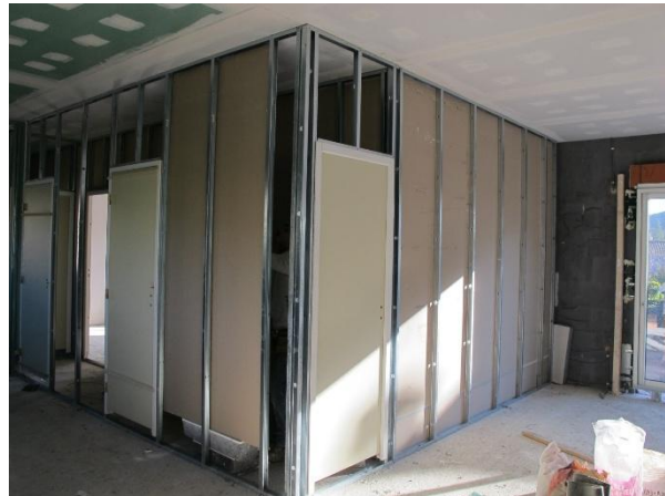
Figure 3.31 : Cloison en Placoplatre
