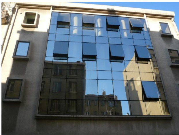
Figure 3.33 : Mur rideau avec ouvrant à l'italienne cache
