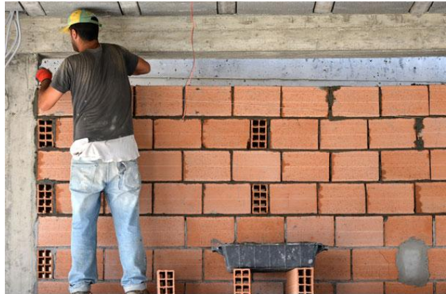
Figure 3.30 : Mur en maçonnerie
