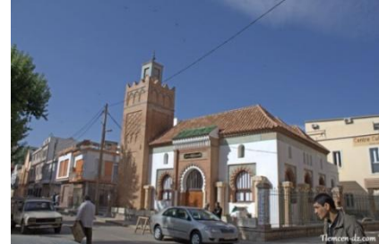
Mosquée Sidi Belahcen
