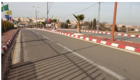
Figure 2.12 : voie à l'est du site
