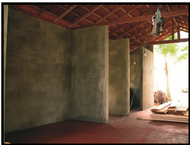
Figure 48: noyau de ciment en forme U
