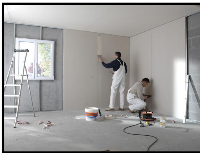
Figure 87: pose de plaque de plâtre BA13
