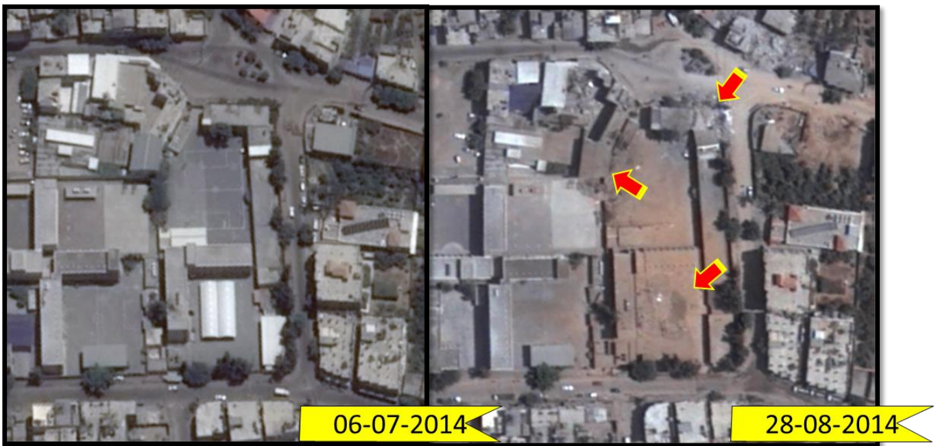
Figure 69 : Dommages d'Ecole Al Shuja'eya
