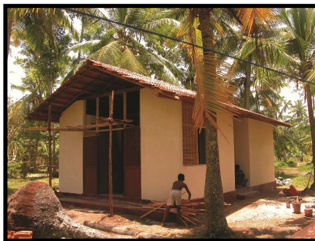
Figure 49: construction de maison
