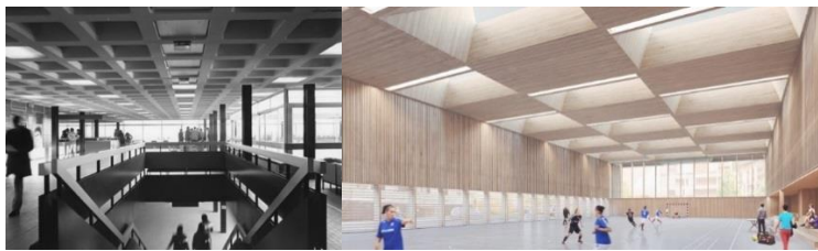
Figure 71 : Exemple d'utilisation du plancher caisson
