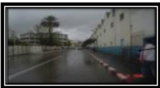
Photo 45 : photo sur la façade nord
