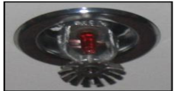
Photo 72 : Un extincteur automatique.
