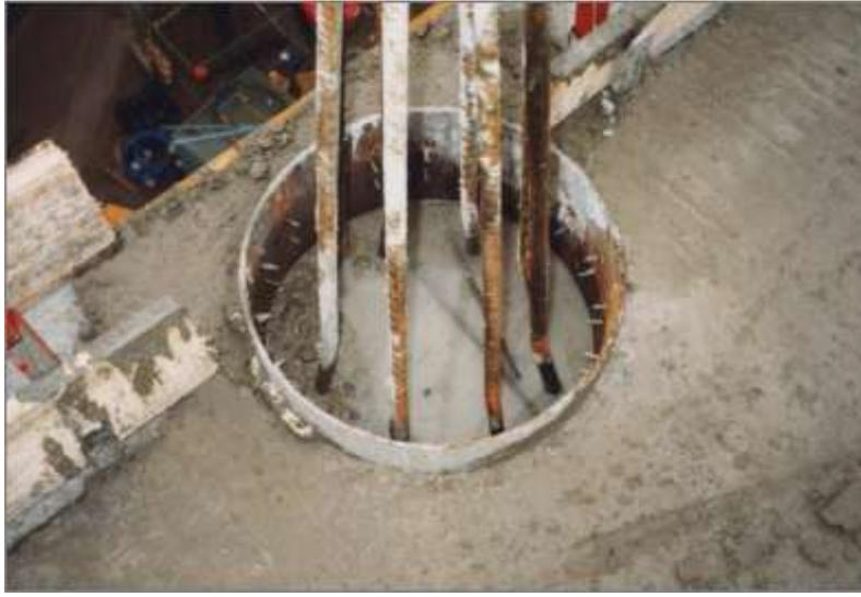
**Figure 33 :** Poteau tubulaire avec clous tirés au pistolet comme connecteur de cisaillement et armatures sur chantier
