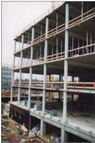
Figure 24: Poteaux et dalles sur chantier
