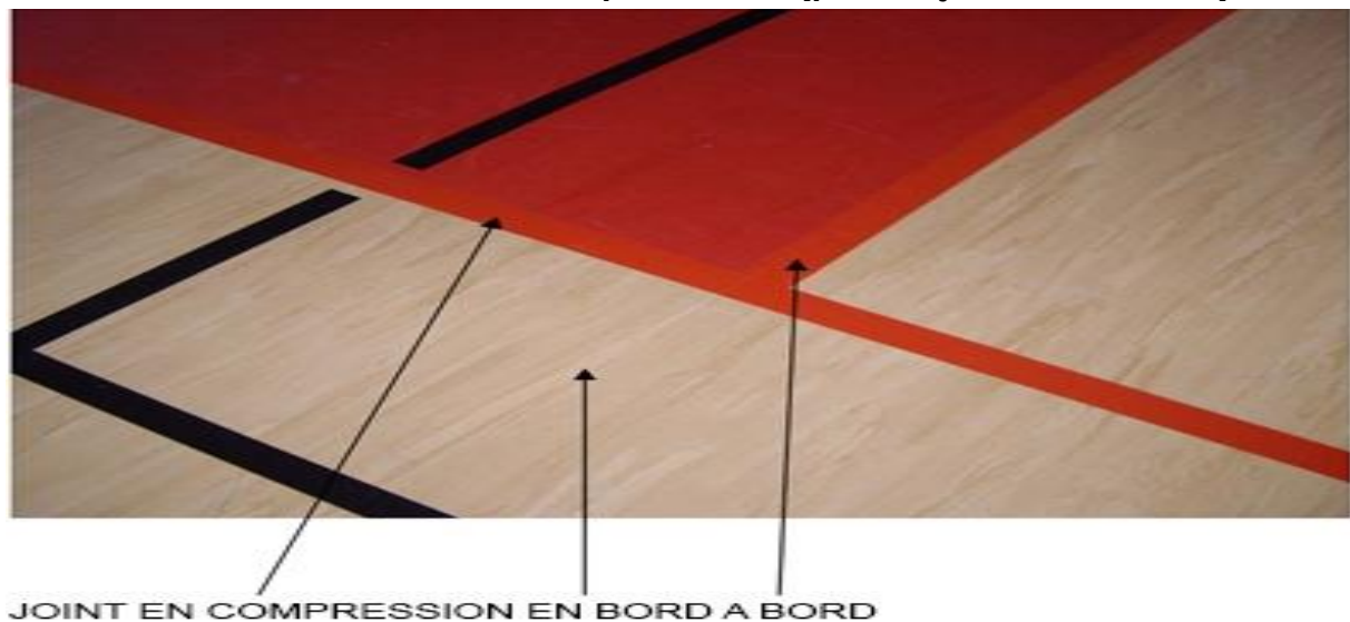
Figure 49 Qualité mise en œuvre et aspect visuel du revêtement
