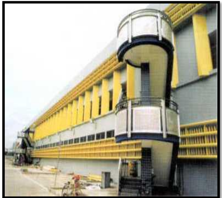
Figure 28. Louvres acoustiques pour l'atténuation du bruit
