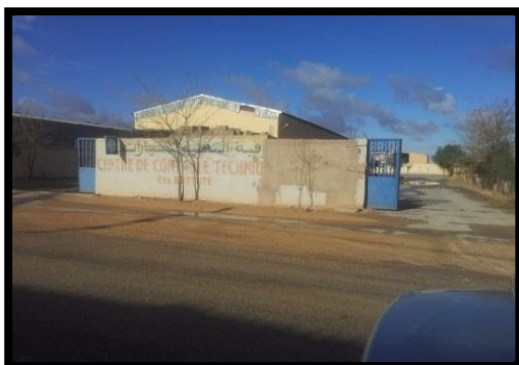
Figure 20.Centre de contrôle technique
