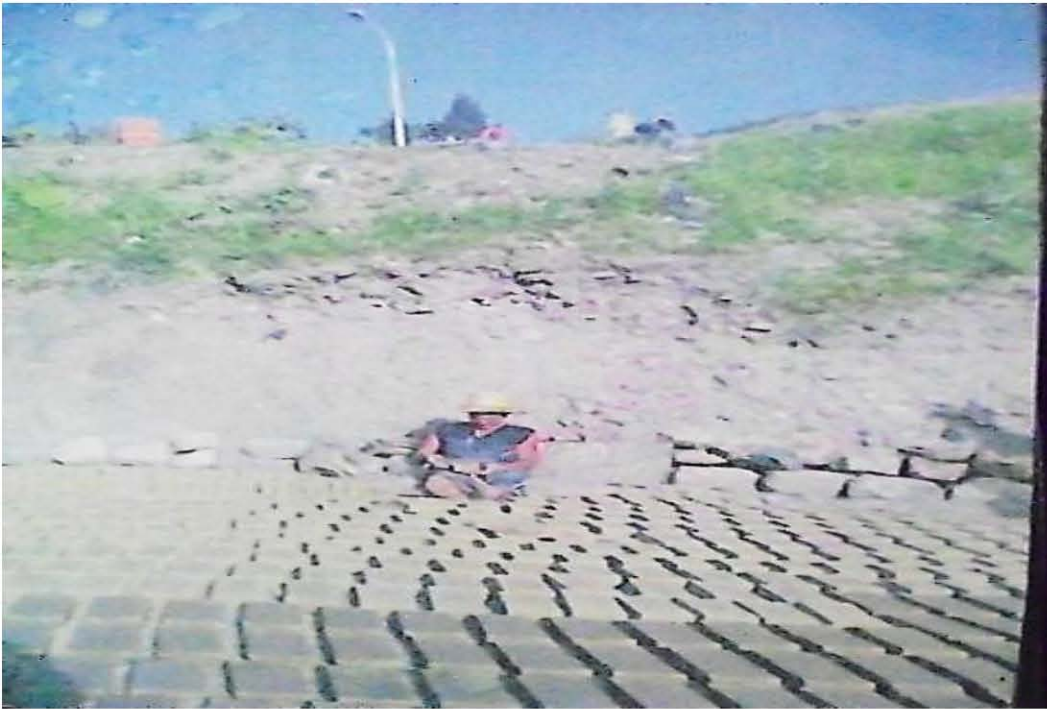
صورة رقم (2): صورة قديمة تبين صفوف من قوالب اللبن وتعرضها للحرارة (ميلة)
