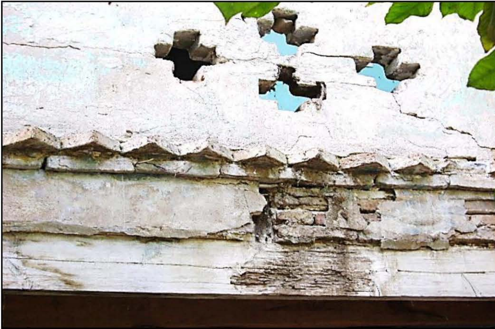
صورة رقم ( 1 ): تبين الطريقة المستعملة في امتصاص الارتجاج الصادر عن سطح بني بعوارض خشبية
