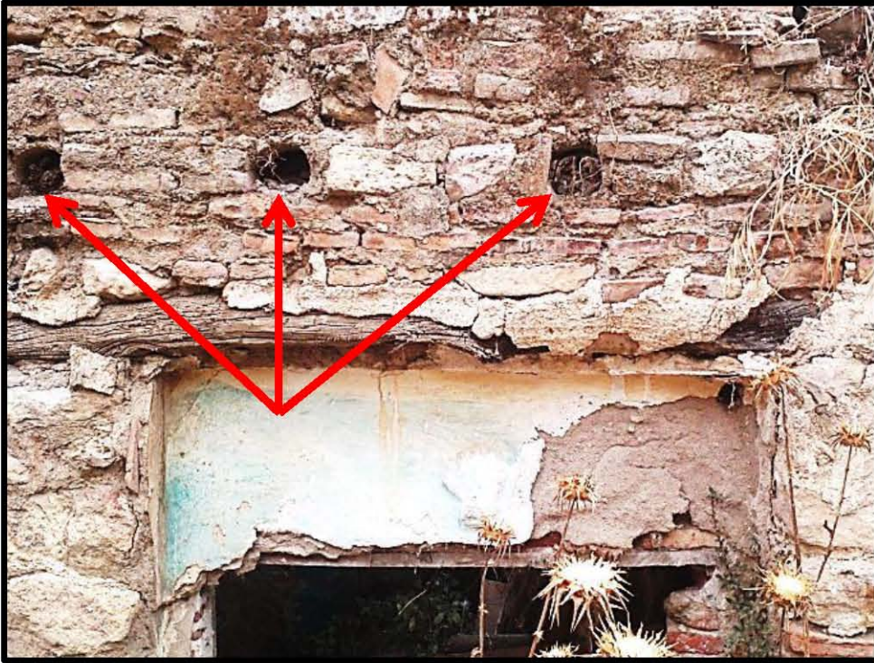
صورة رقم (1): توضح الثقوب التي كانت مستعملة في حمل شرفة الطابق العلوي للمسكن (نموذج 1)
