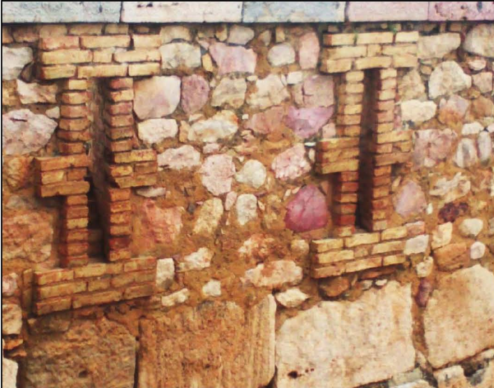
صورة رقم (2): نموذج آخر للمزاعل الموجودة بالسور العتيق
