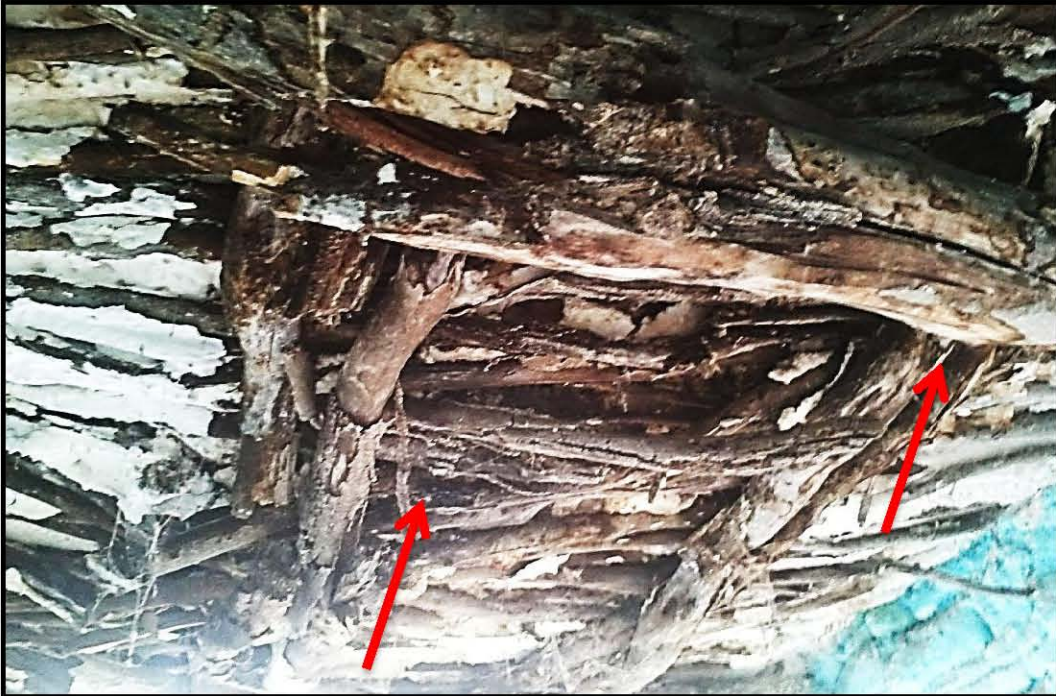
صورة رقم ( 1 ): تبين شكل الكوافة المتواجدة بأحد غرف المسكن النموذجي الأول
