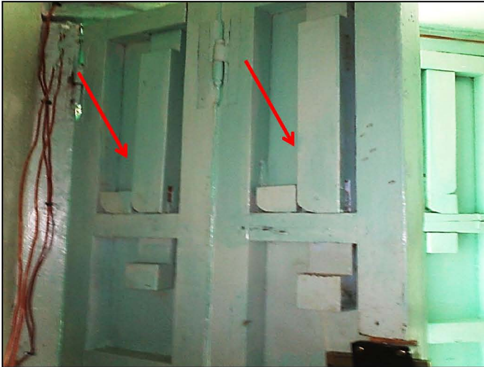
صورة رقم ( 2 ): تبين المغالق المستعملة فى غلق أبواب الزاوية الرحمانية.
