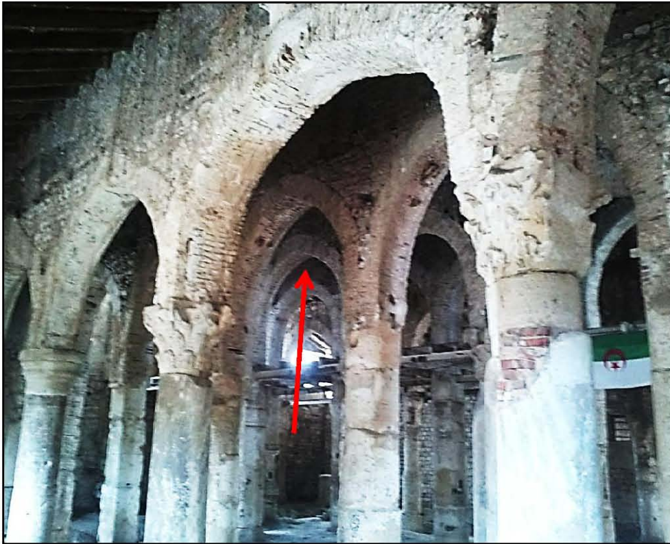
صورة رقم (2): تبين شكل الأقواس وأعمدة ببيت صلاة أبو المهاجر دينار
