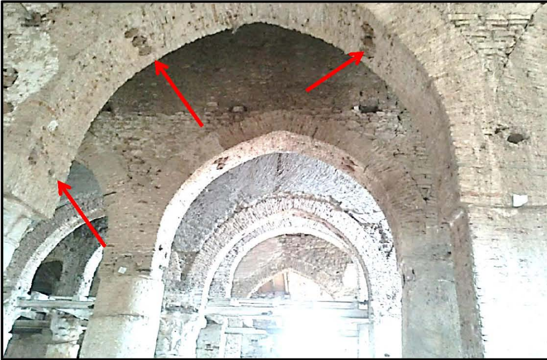
صورة رقم (2): تبين الفتحات الخاصة بالعوارض الخشبية لأقواس مسجد أبو المهاجر دينار.
