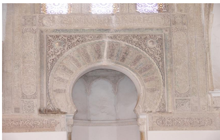
الصورة رقم 40: الاطر الهندسية لتوزيع الحشوات الزخرفية. بمسجد سيدي ابي الحسن
