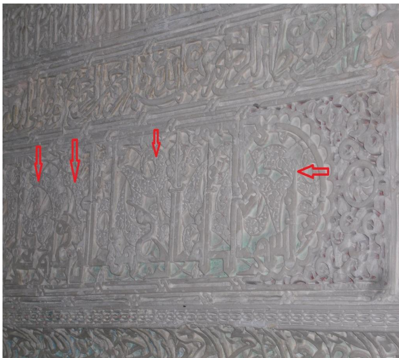
الصورة رقم 23: المراوح الموردة بواجهة مسجد سيدي ابي الحسن
