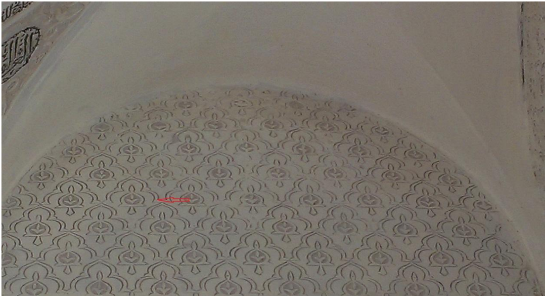
الصورة رقم 10: المعينات الهندسية اسفل قبة ضريح سيدي ابي مدين
