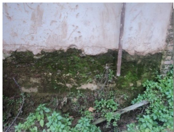
الصورة رقم: 05 تطوّر الكائنات الدقيقة على جميع قواعد الجدران. الصورة رقم: 06 نموّ النباتات.
