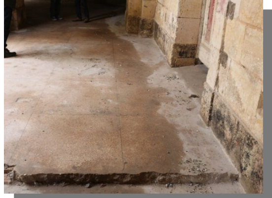
الصورة رقم: 112 ارتفاع نسبة الرطوبة في الأرضيات. الصورة رقم: 113 اتساخ الجدران ولاسيما في أماكن سيلان المياه بسبب الغبار والملوثات الجوية.
