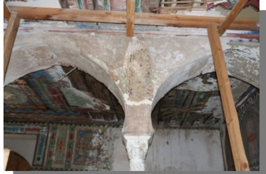
الصورة رقم: 77 سقوط الزخارف الجصية . بسبب الرطوبة والأملاح
