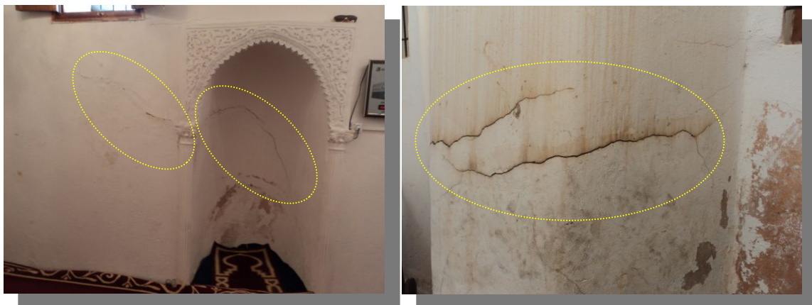
الصورة رقم: 63 انتفاخ الجدران وتقشر الطلاء بسبب الرطوبة ذات المصادر المختلفة.
