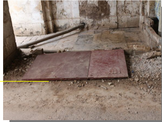
الصورة رقم: 107 استحداث قنوات صرف صحي.
