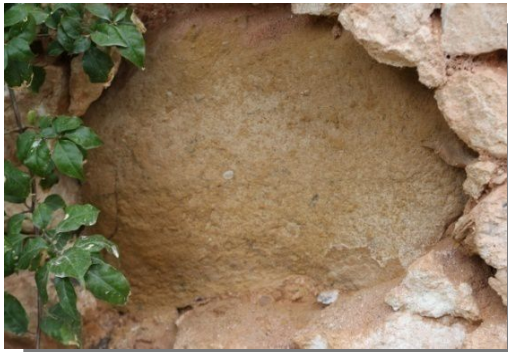
الصورة رقم: 82 هشاشة الملاط الرابط بين المواد
