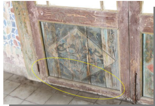
الصورة رقم: 81 ارتفاع الرطوبة بالخاصية
