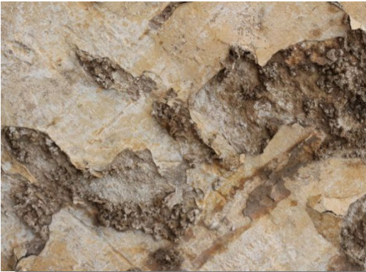
الصورة رقم: 115 سمك الأشنات على الأسطح. الصورة رقم: 116 تزهير الأملاح على الأسطح.
