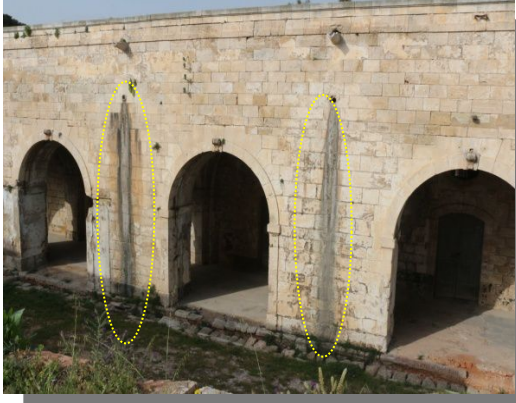
الصورة رقم: 112 ارتفاع نسبة الرطوبة في الأرضيات. الصورة رقم: 113 اتساخ الجدران ولاسيما في أماكن سيلان المياه بسبب الغبار والملوثات الجوية.
