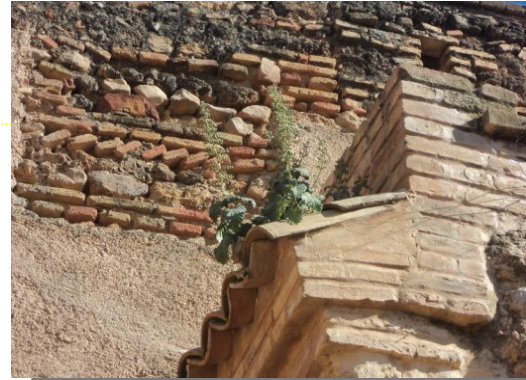
الصورة رقم: 134 قصر سيدي بومدين الصورة رقم: 135 منظر لتآكل الملاط الرابط بين المواد.
