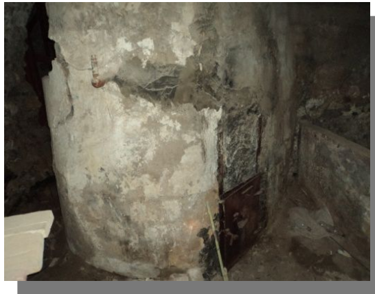
الصورة رقم: 16 تصدع وانحيار أجزاء من مبنى الحمام.
