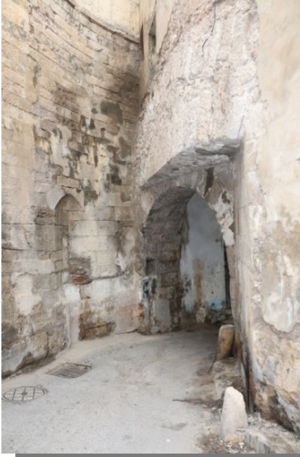
الصورة رقم: 129 ارتفاع نسبة الرطوبة في الجدران مياه الصرف الصحي للسكان.
