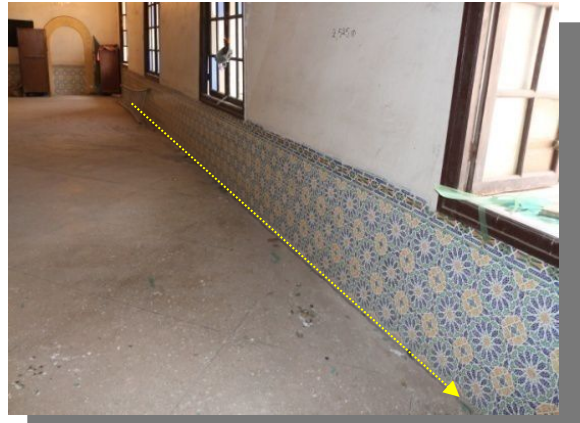
الصورة رقم: 69 شق على طول الجدار وميلانه بسبب انزلاق التربة
