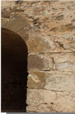
الصورة رقم: 133 منظر لتآكل الملاط الرابط بين المواد
