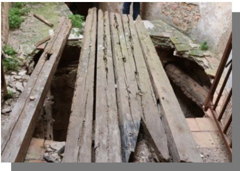
الصورة رقم: 101 انهيار سقف الطابق الأرضي .
