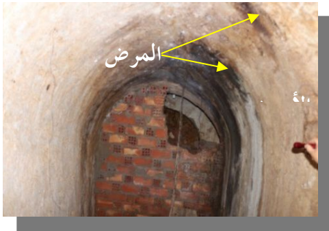
الصورة رقم: 99 تبلور الأملاح على السقف.
