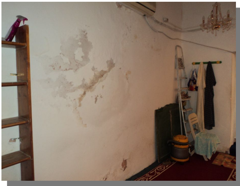
الصورة رقم: 63 انتفاخ الجدران وتقشر الطلاء بسبب الرطوبة ذات المصادر المختلفة.
