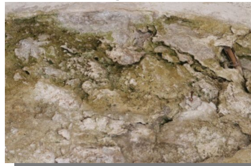
الصورة رقم: 77 سقوط الزخارف الجصية . بسبب الرطوبة والأملاح
