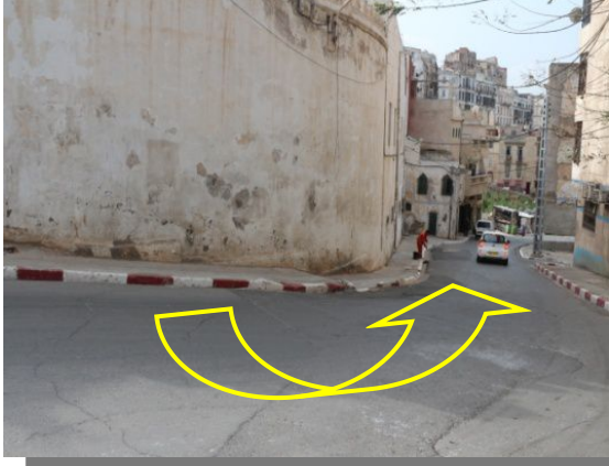
الصورة رقم: 70 مكان انزلاق التربة بسبب مياه الصرف الصحي.
