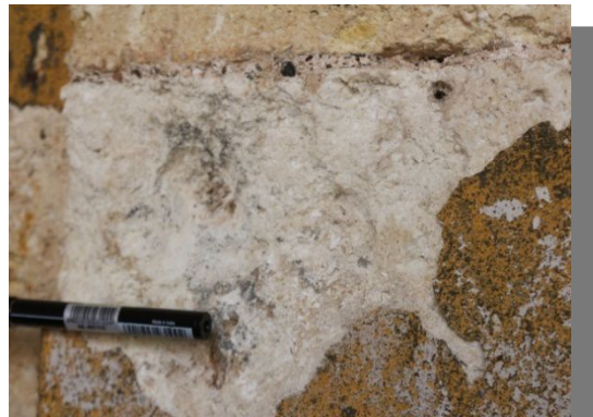
الصورة رقم: 115 سمك الأشنات على الأسطح. الصورة رقم: 116 تزهير الأملاح على الأسطح.
