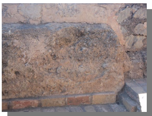
الصورتين رقم: 41-42 ظهور المرض الأسود على الأسطح. الصورة رقم: 43 تبلور الأملاح على الأسطح. الصورة رقم: 44 تآكل مواد البناء.
