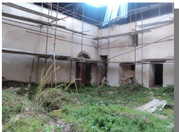
الصورة رقم: 05 تطوّر الكائنات الدقيقة على جميع قواعد الجدران. الصورة رقم: 06 نموّ النباتات.
