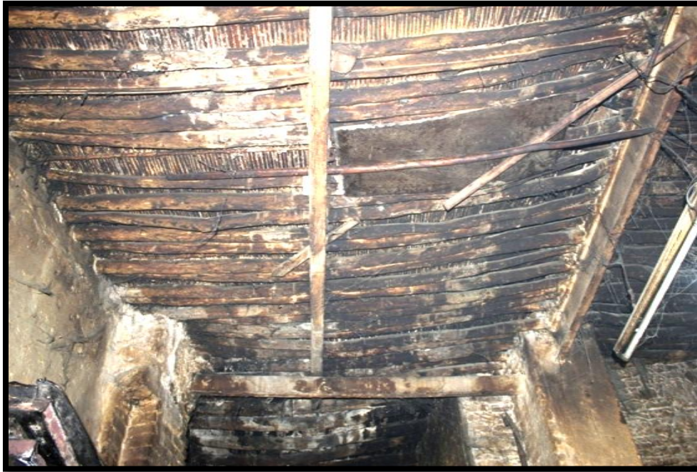
الصورة رقم 15: توضح الصورة السقف الخشبي للفران وعناصر تدعيمه
