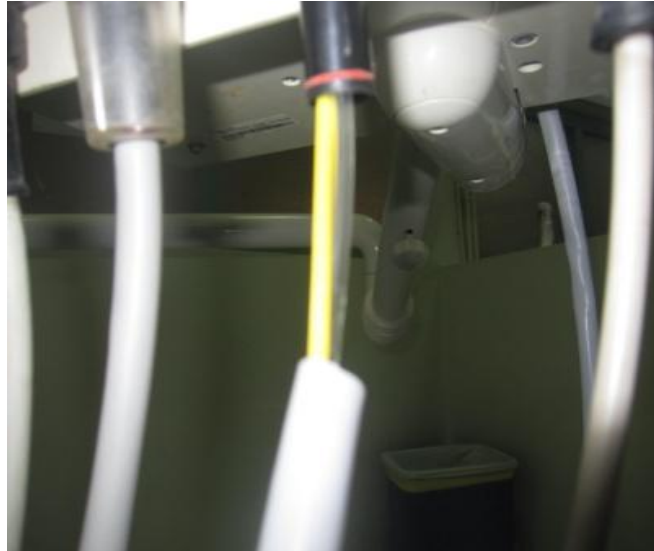
Figure 8: Emplacement d'une tubulure neuve.
