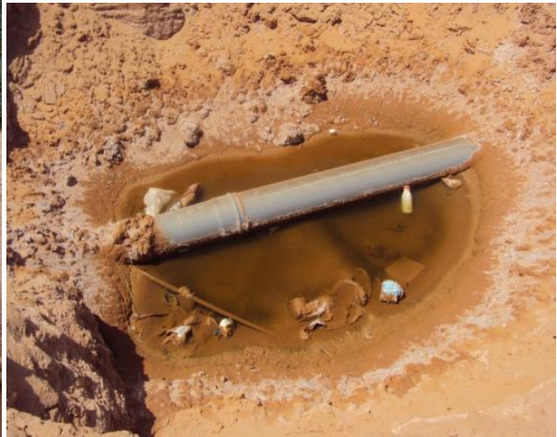
(b)- Conduite d'assainissement dans la nappe
