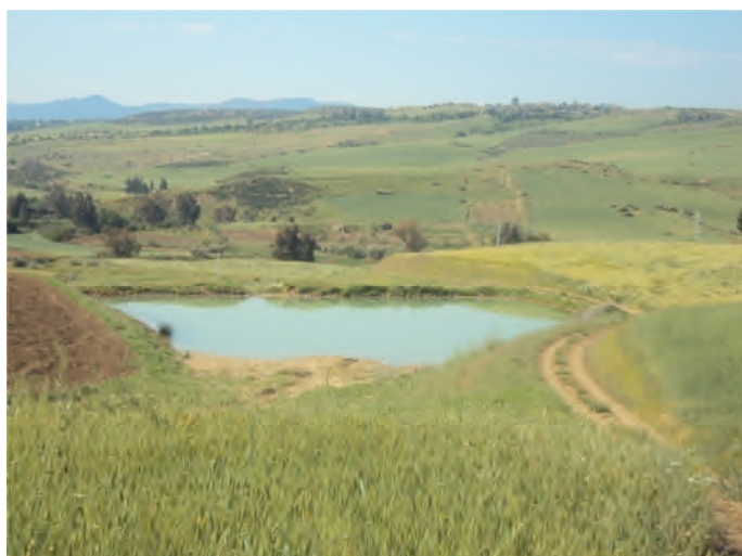
c) Seuil en terre compactée sur les terrains marneux, ayant un triple rôle : bloquer l'érosion linéaire, stocker les sédiments derrière les petits seuils et capter de l'eau pour abreuver le cheptel et produire du fourrage.
