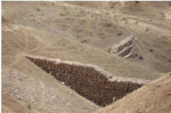
a) Les seuils, de correction torrentielle ne sont pas adaptés au terrain marneux
