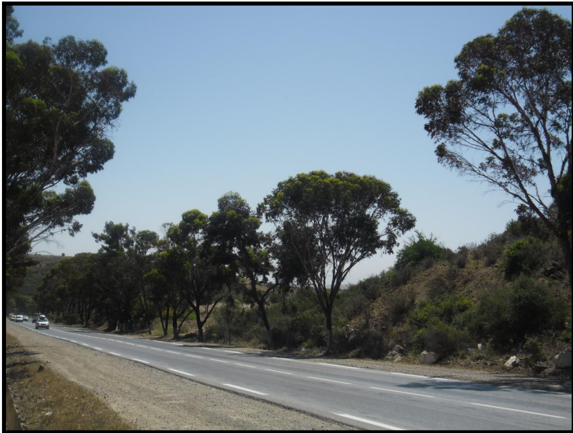
Photo n°11 : La station de Nedroma 2015 (prise par Mekelleche H)
