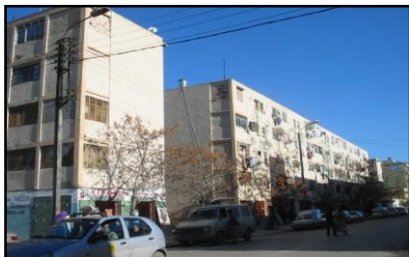
Figure 44. Bâtiment collectif - Hai El Hamri
