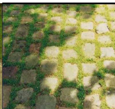
Pave de grés a joints engazonnes sans solvant
