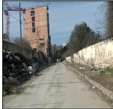
Figure 70. Photo sur une voie à l'intérieur de tissus montre les déchets solides.
