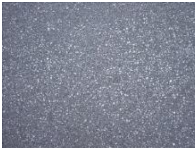
Béton bitumineux noir renforce
