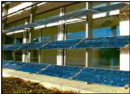
Photo 11 : Panneaux intégrés sur les brise-soleils
