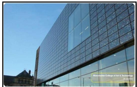
Photo 15 : Exemple d'un mur capteur
