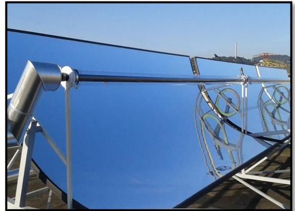
Photo 05 : Les capteurs cylindro-parabolique
