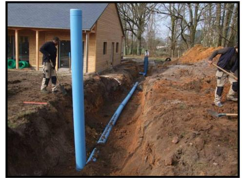
Photo59 : Des conduits pour le passage de l'air.
