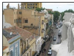
Figure 40: photo aérienne de la rue de France
