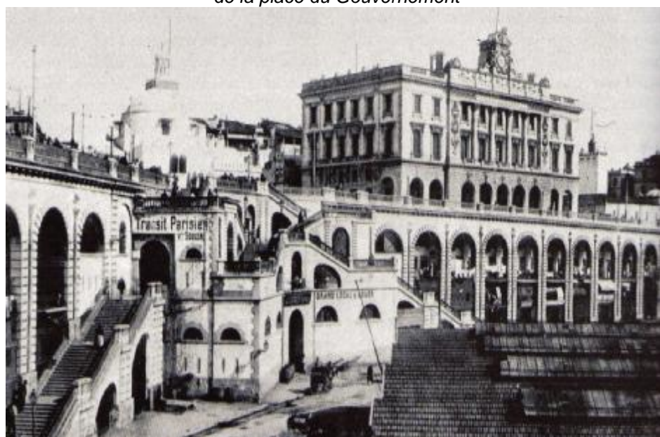
Figure 15 : Vue sur lieu de Bab El Bahr après aménagement des escaliers de la pêche
