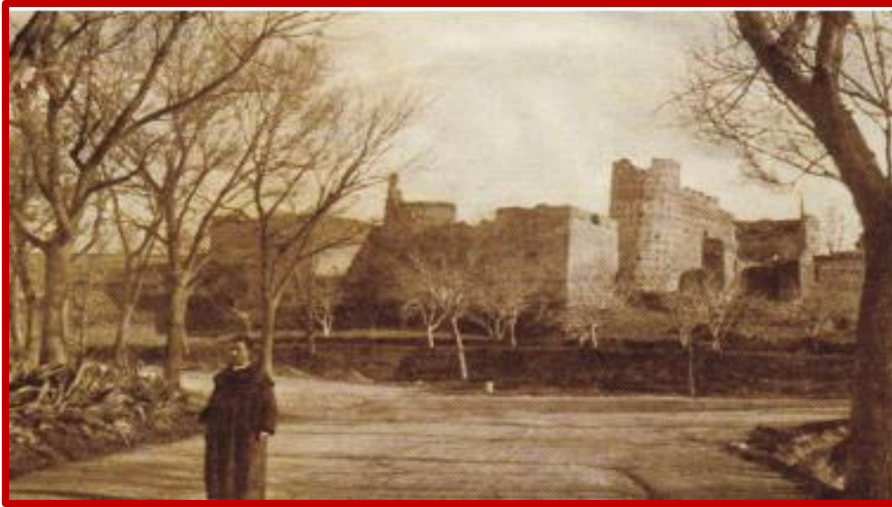
Figure 9 : Vue Sur La Porte Depuis Le Côté Nord
