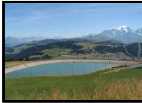
Figure 6: Retenue collinaire à Tissemsilt , Algerie
